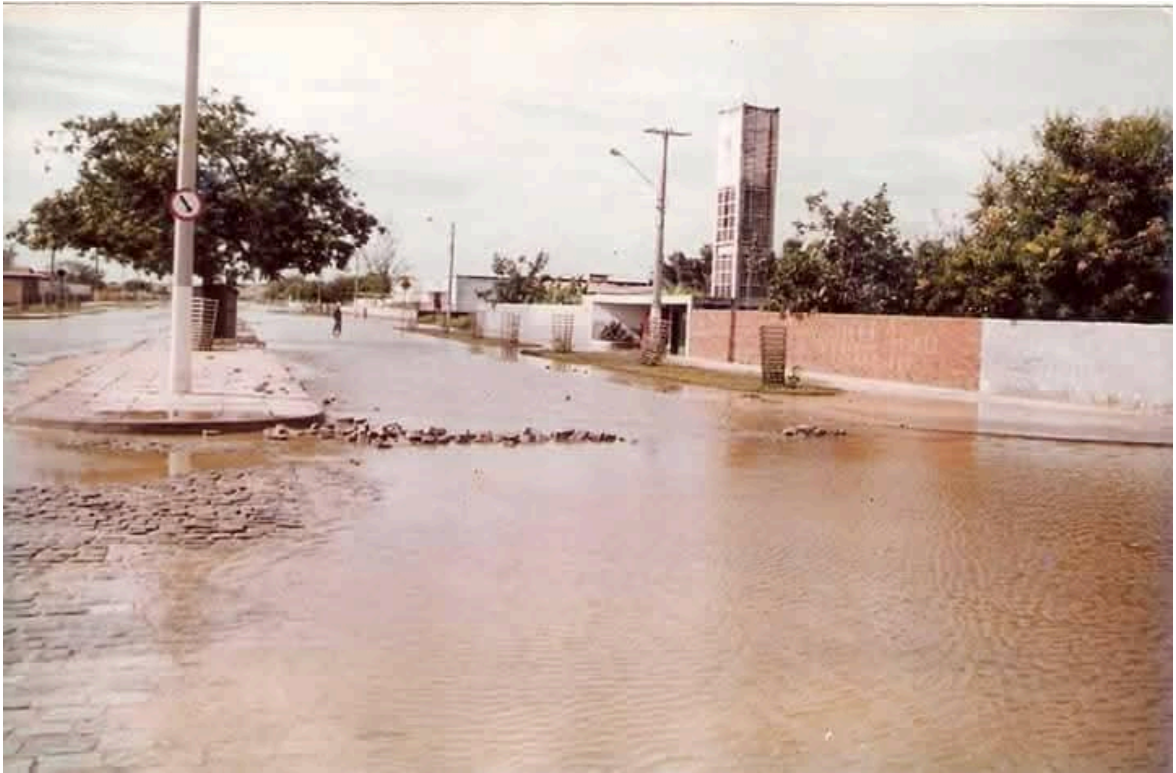
Figura 9 - Alagamento da Rua Manoel de Castro, Centro de Morada Nova, em 1984
