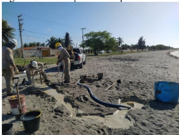
Figura 47 - Execução do furo para o ensaio PMT-1.
