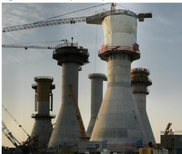
Figura 24 - Fundação do tipo Base de Gravidade.
