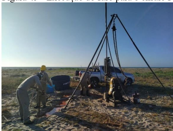
Figura 49 - Execução do furo para o ensaio PMT-3.
