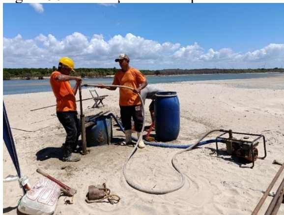
Figura 50 - Execução do furo para o ensaio PMT-4.
