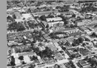
Vista aérea do Campus do Poranguabuçu - Área 02 - Fonte: COP - UFC INFRA
