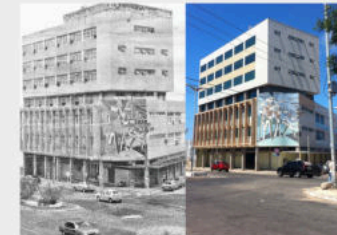
Centro de Exportadores do Ceará. Foto antes e após retrofit. Fonte: Acervo LoCAU.
