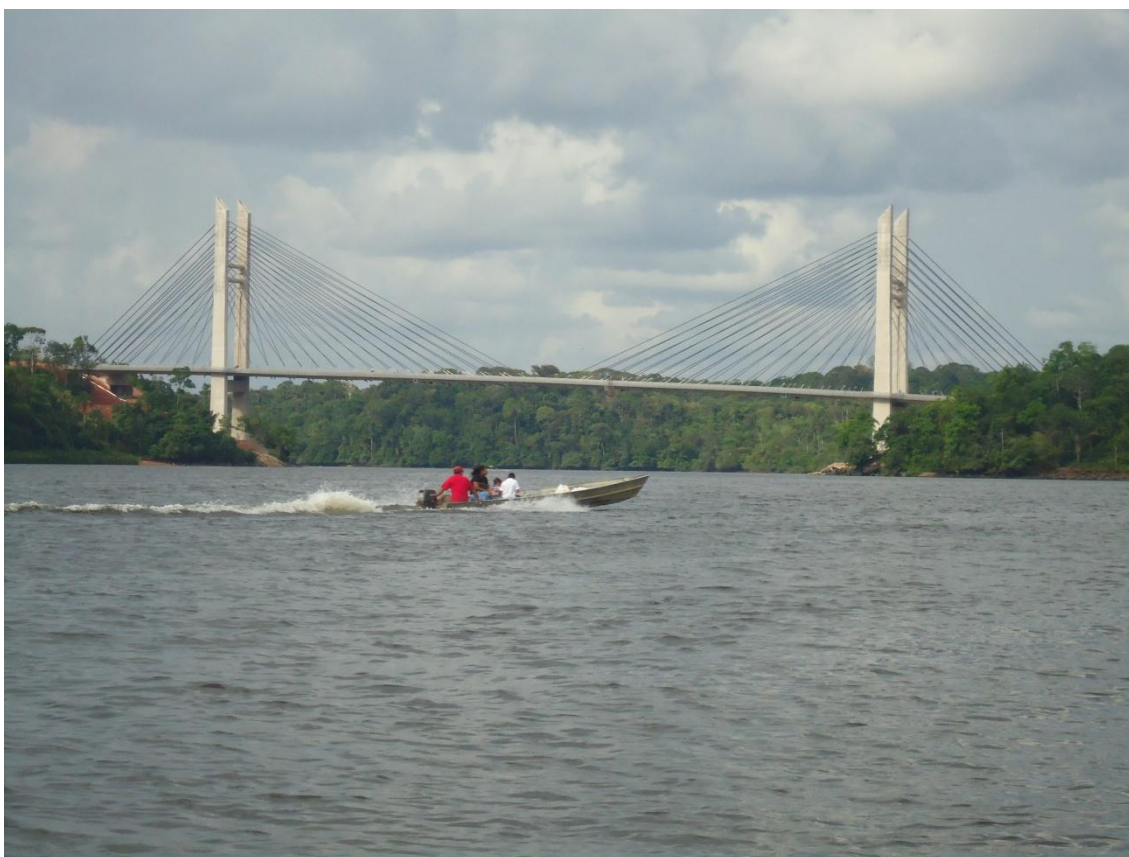
Imagem 26 – Ponte binacional sobre rio Oiapoque
