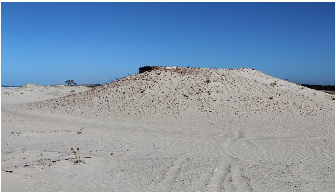
Figura 7- Edificação totalmentedeteriorada pela ação eólica
