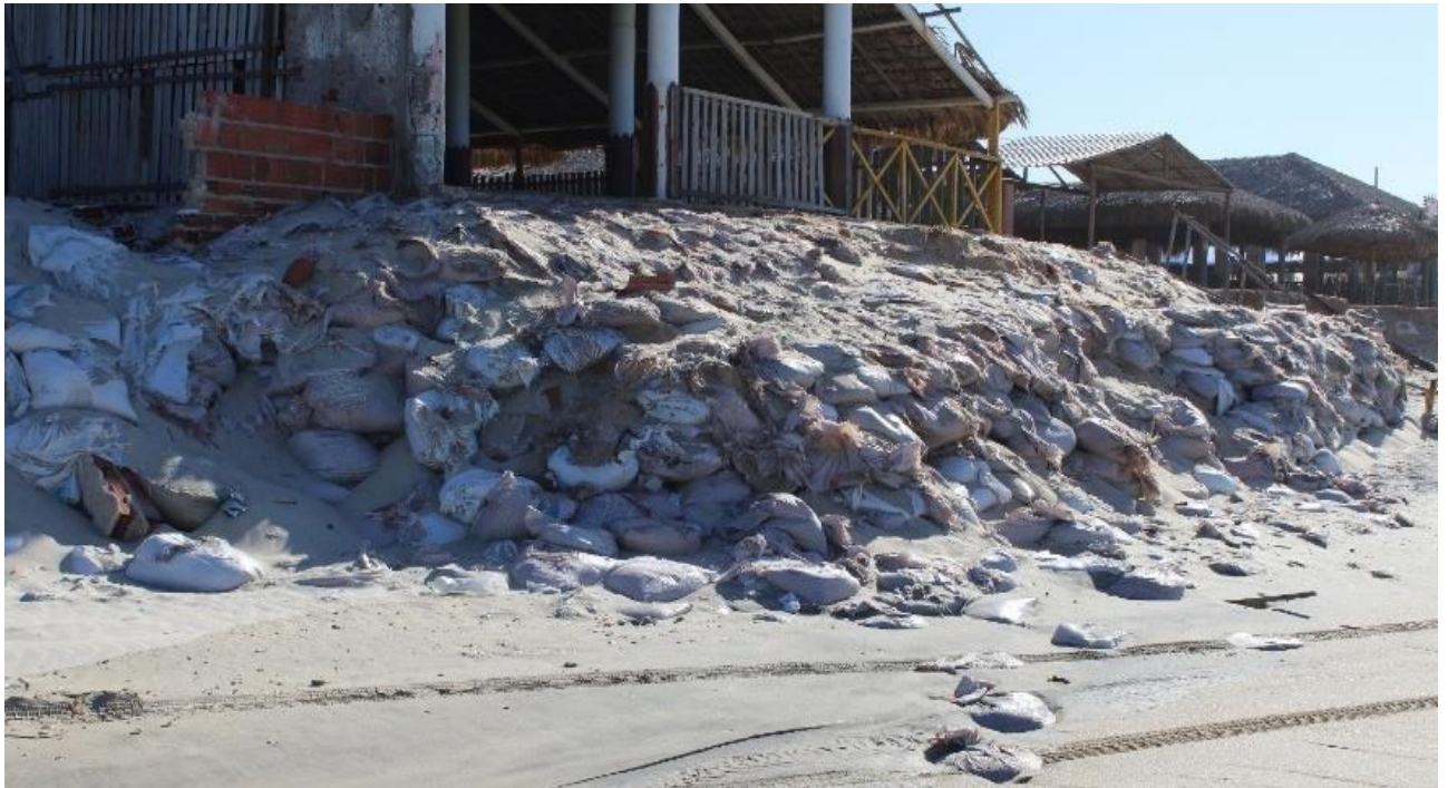
Figura 24- Materiais improvisados na pós-praia como tentativa de conter a erosão
