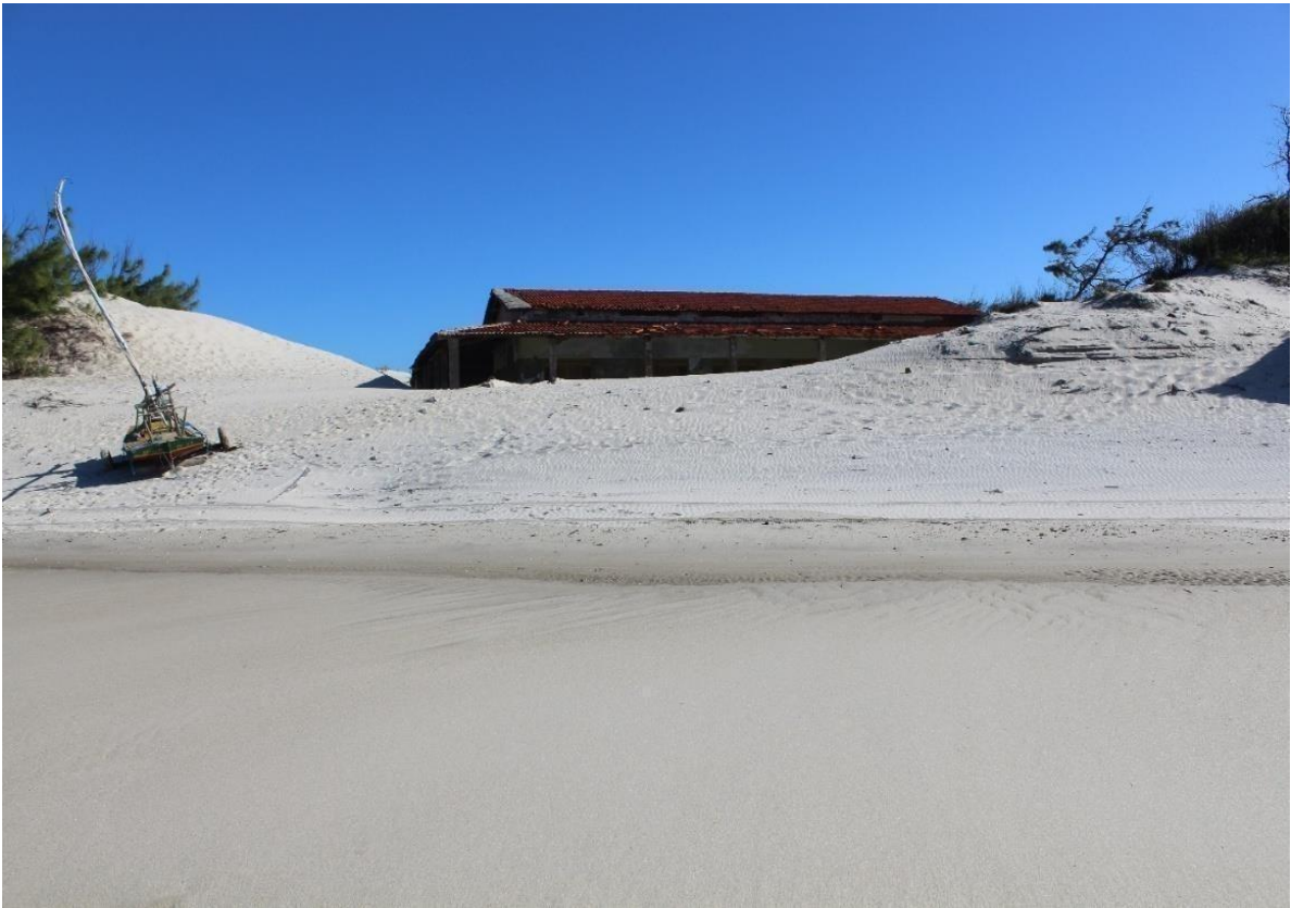
Figura 6- Residência soterrada pela duna móvel em razão do intenso fluxo sedimentar
