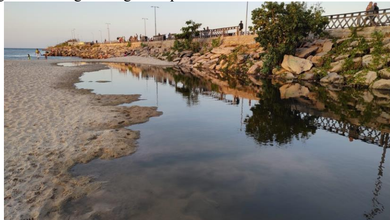
Figura 8 - Imagem da galeria pluvial localizada na Praia de Iracema.
