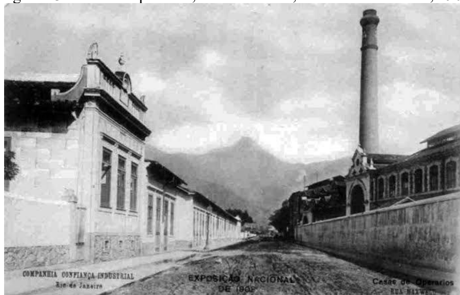
Figura 13 – Casa de operários, Rua Maxweld, Rio de Janeiro – RJ, 1908
