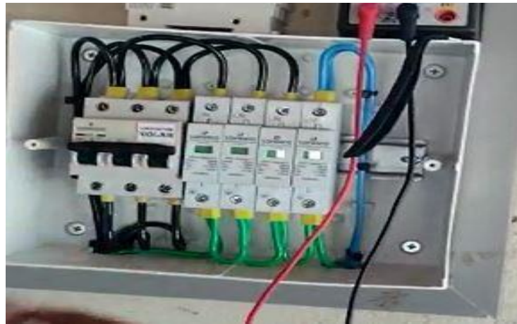
Figura 40- Execução da proteção CA – Barroquinha (CE).
