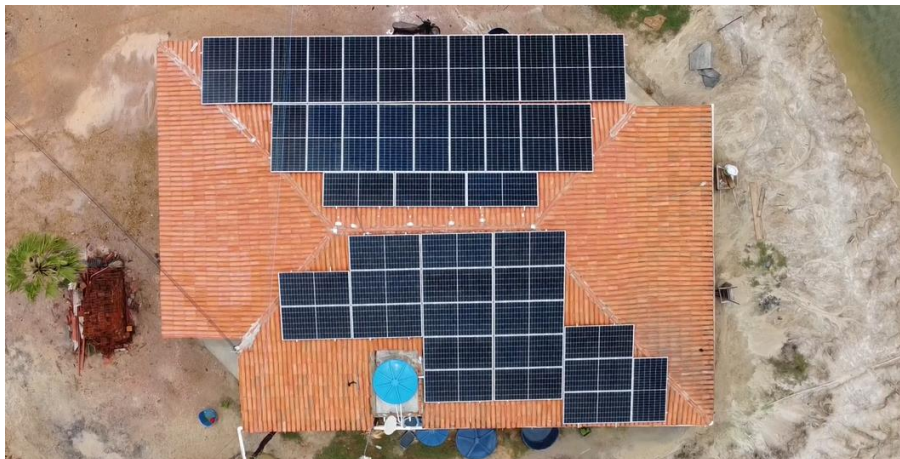
Figura 54- Execução do sistema fotovoltaico - Barroquinha (CE)
