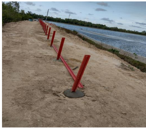
Figura 45- Etapa de concretagem da mesa solo.
