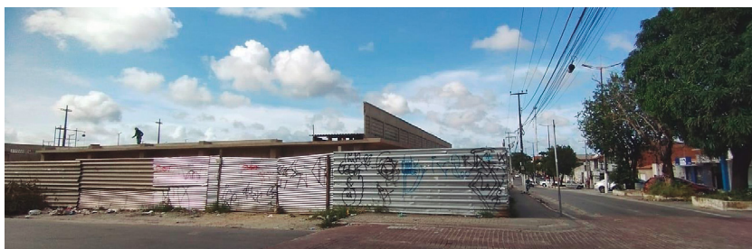
Figura 6 – Obra do Mercado da Jurema
