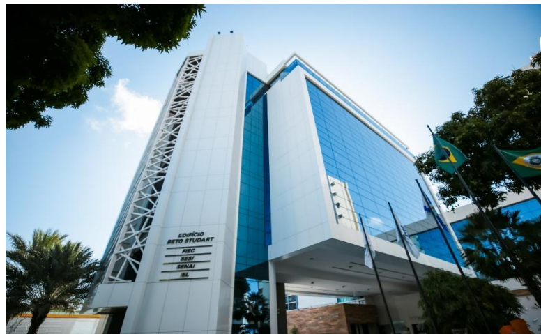
Figura 2 - Fachada do edifício da FIEC, Fortaleza-CE
