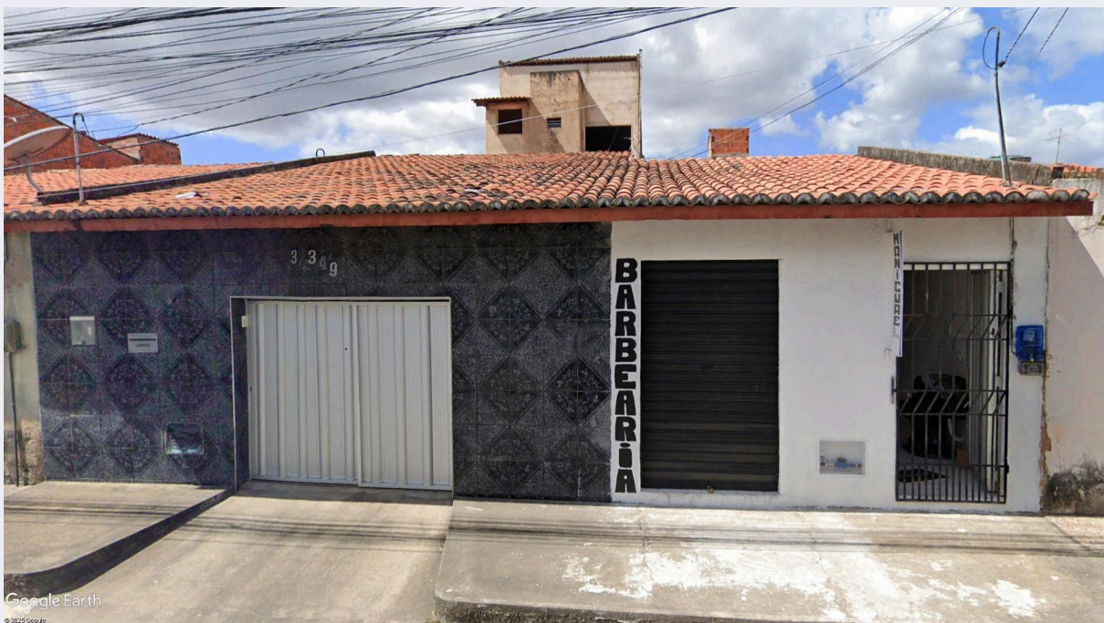
Figura 151: Fachada da Casa 349
