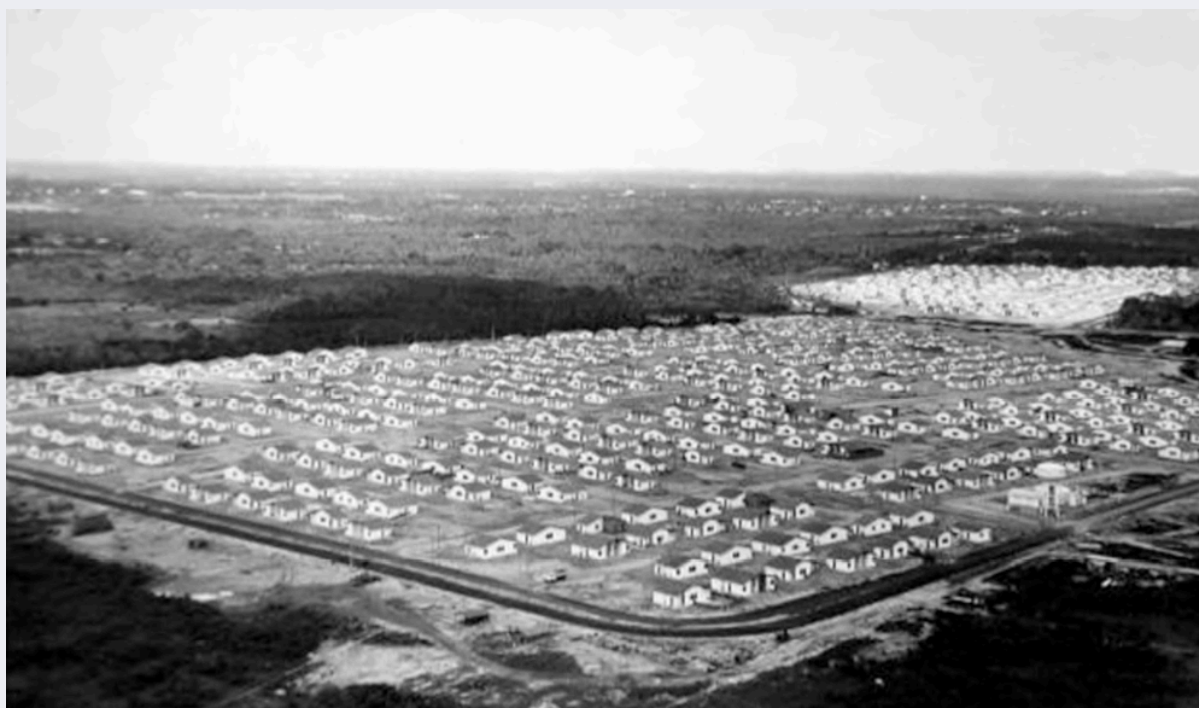
Figura 17 – Imagem aérea de trecho do Conjunto Industrial, construído pelo BNH em Maracanaú
