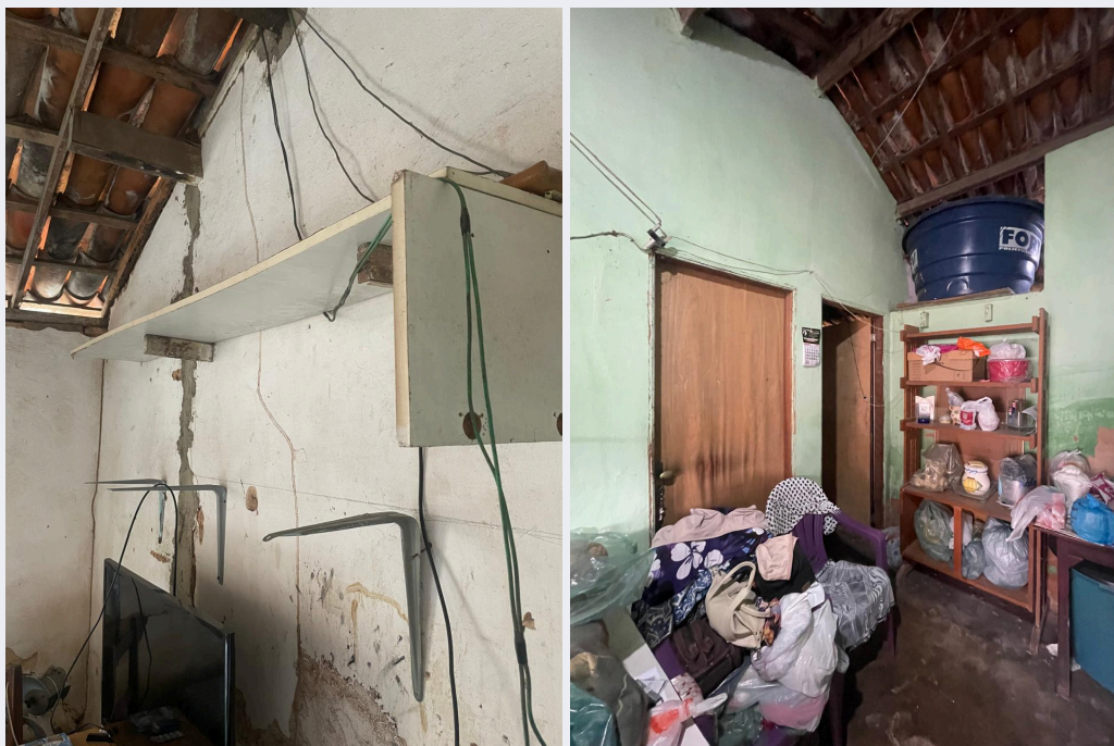
Figura 114: Fiação exposta.
