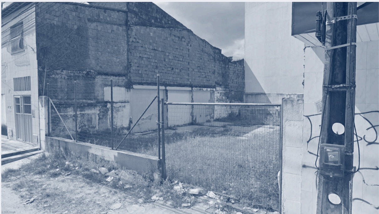
Figura 83 – Atual estado do imóvel de Francisca
