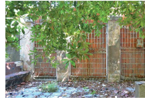
1 Entrada original - colunas que demarcam a entrada com pintura original desgastada - cor rosa, portão metálico de gradil original - pintado cor branco.
