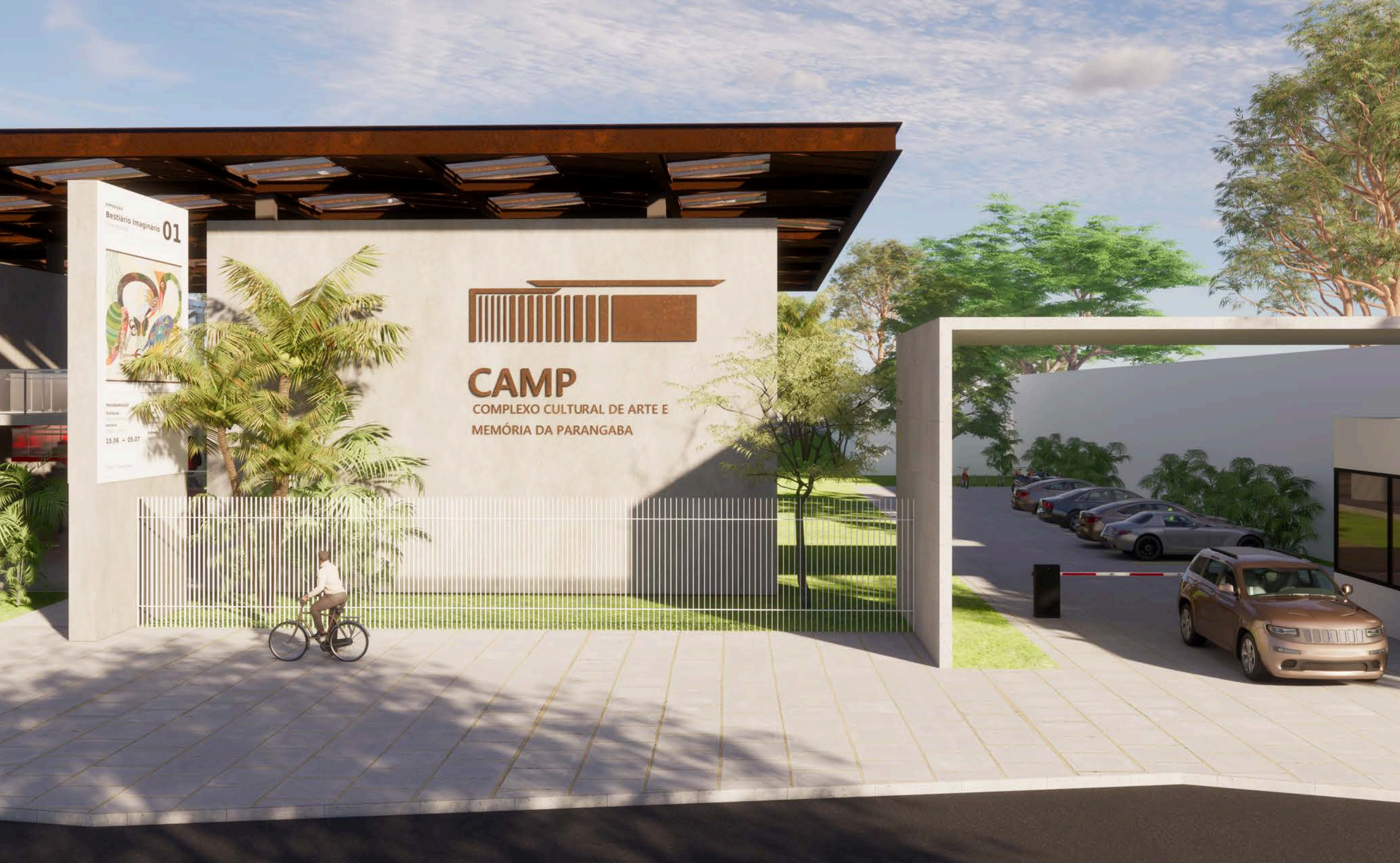
FACHADA DO CAMP - COMPLEXO CULTURAL
