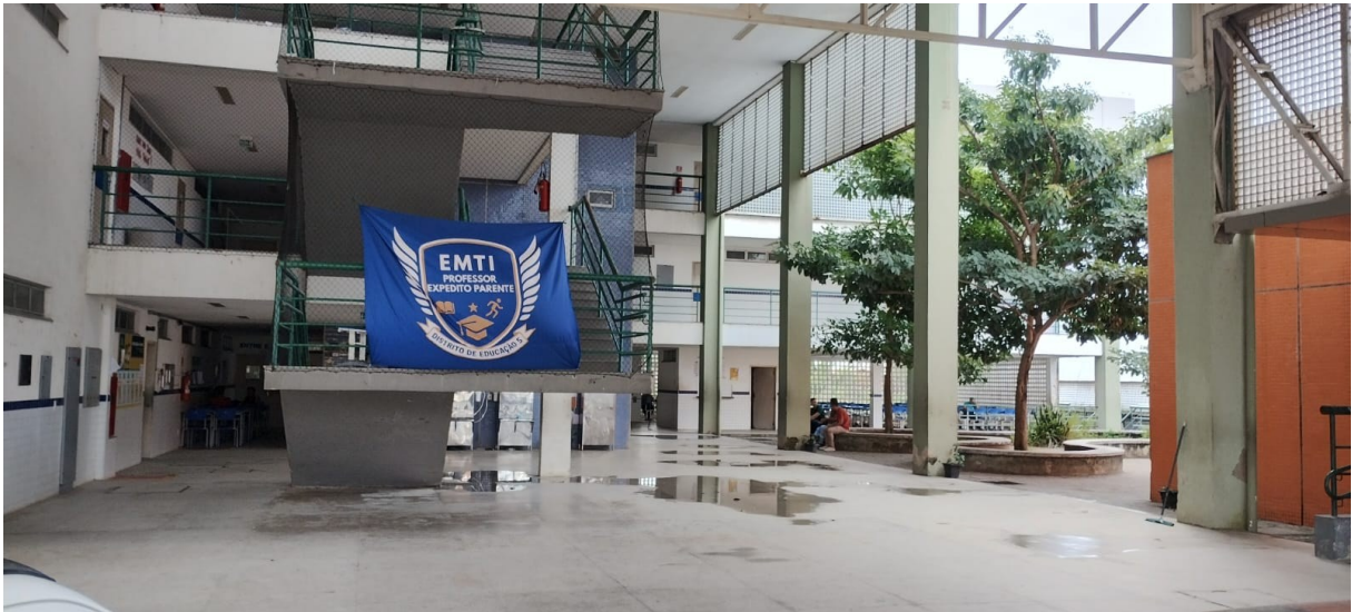
Figura 3 – Pátio coberto da escola.
