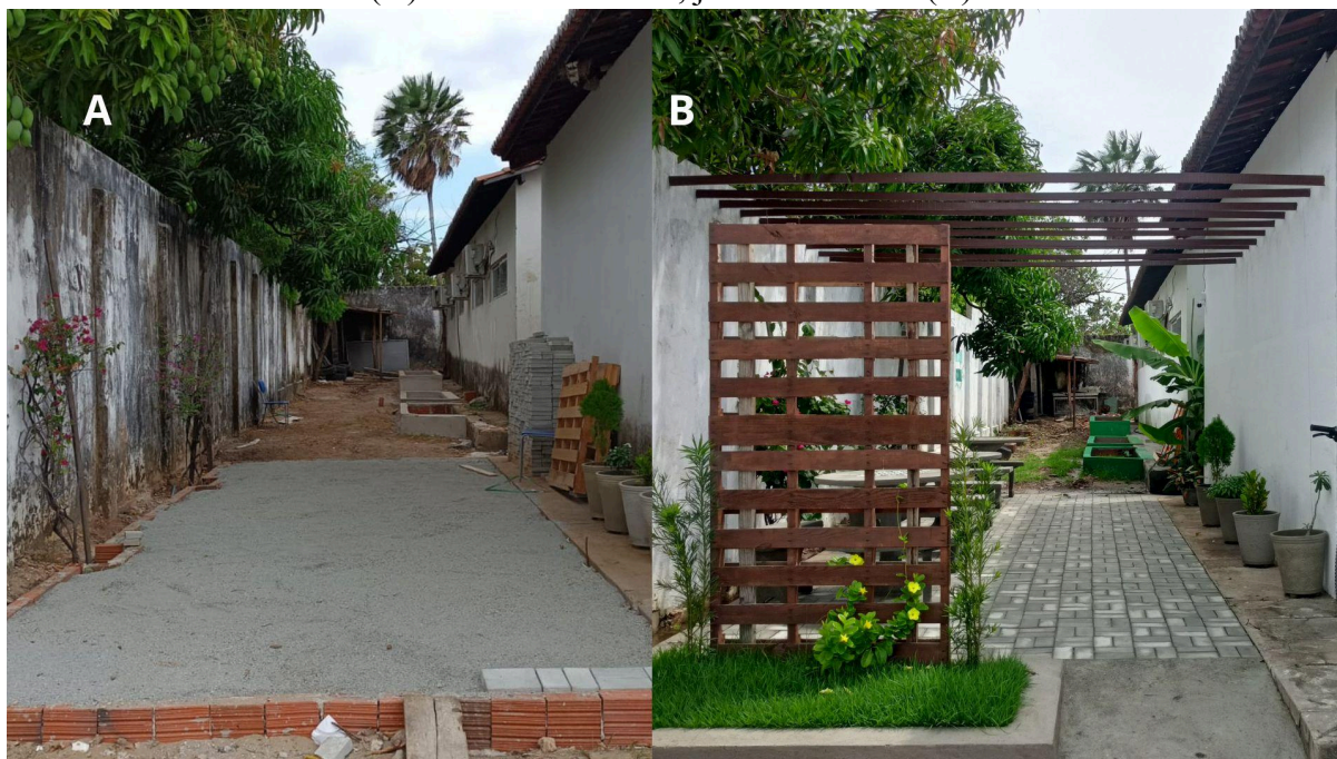
Figura 15 - Área de convivência da escola, com projeto de espaço verde. Imagens no início da obra em outubro de 2025 (A) e no final da obra, janeiro de 2026 (B)
