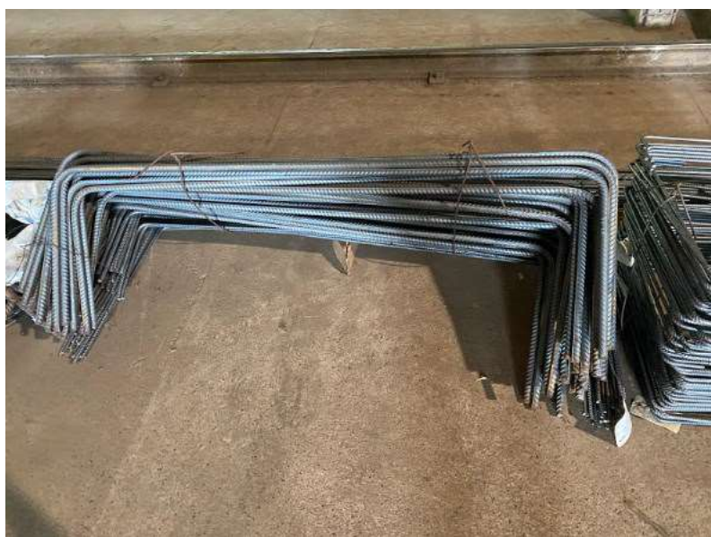
Figura 12 – Barras de aço após o processo de corte e dobra
