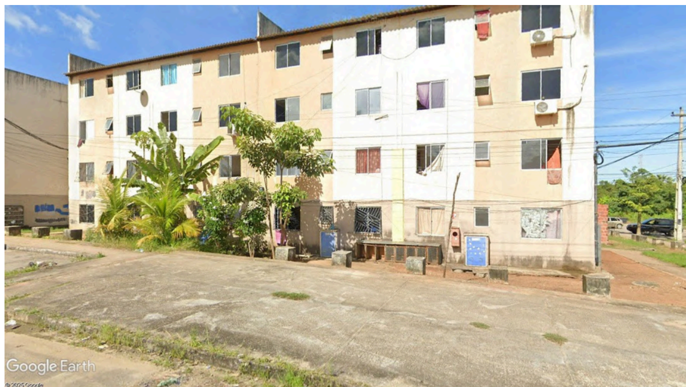
Figuras 18 e 19 - Edifícios dos conjuntos Orgulho do Ceará e Cidade Jardim I, respectivamente.
