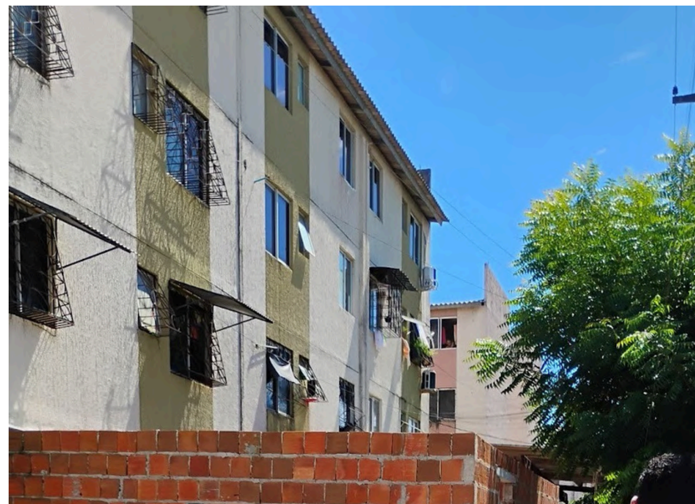
Figura 47 - Estruturas de proteção nas janelas.
