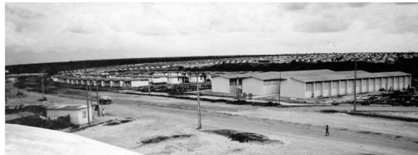
Figuras 01 e 02 - Conjuntos Habitacional Marechal Rondon e Alvorada, respectivamente.
