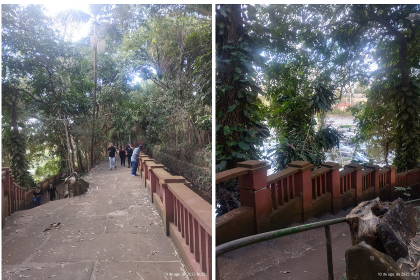
Figura 47 - Parque do Mirante, escadarias e biovaletas.
