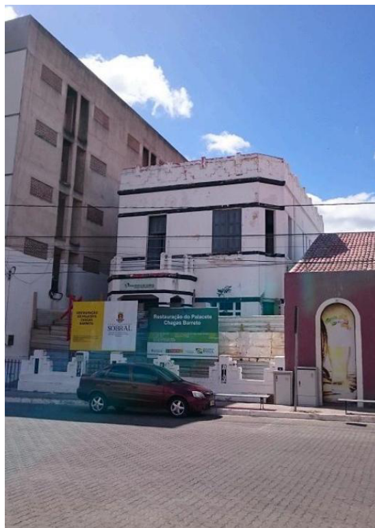
Figura 86: Fachada com tapume de chapa compensada e placa de obra do Palacete Chagas Barreto
