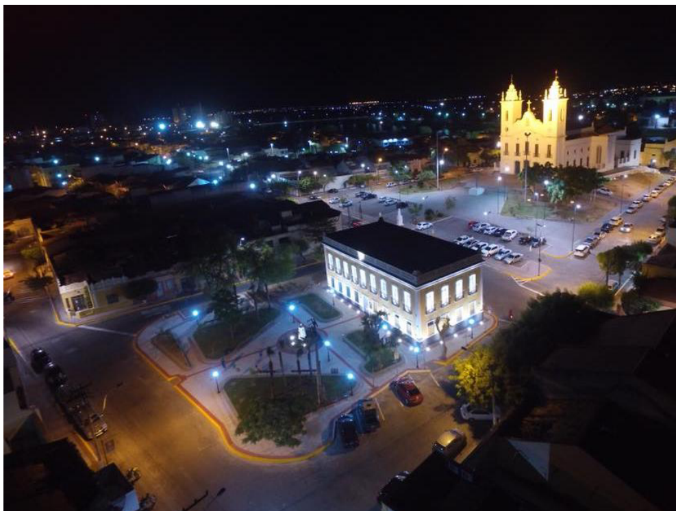
Figura 51: Requalificação da praça da Câmara Municipal de Sobral, em Sobral.
