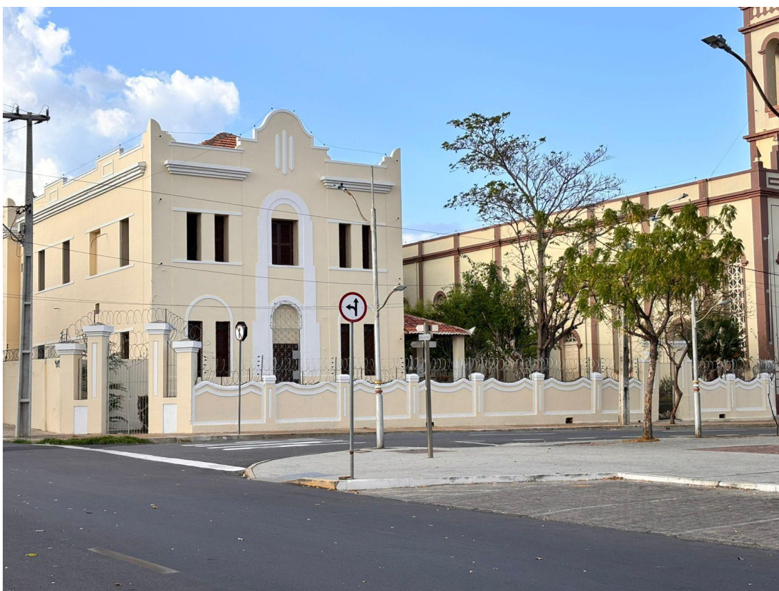
Figura 142: Esquina do Abrigo Sagrado Coração de Jesus, com cruzamento entre a Rua Maestro José Pedro e a rua Paulo Aragão
