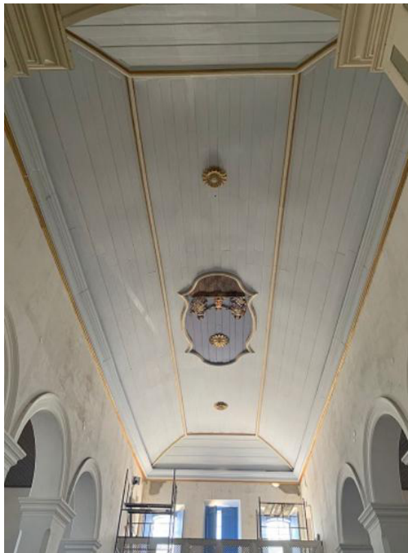
Figura 67: Execução de restauração do forro original da nave central em 2021.
