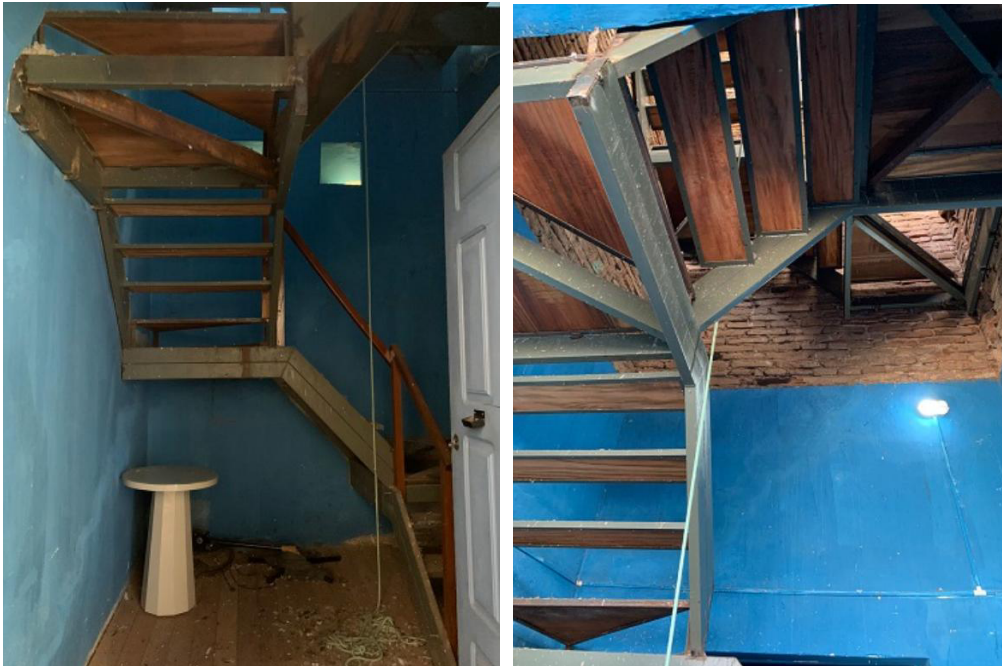
Figura 72: Piso de lambri de madeira, estrutura de metal da escada da torre lateral e piso de madeira
