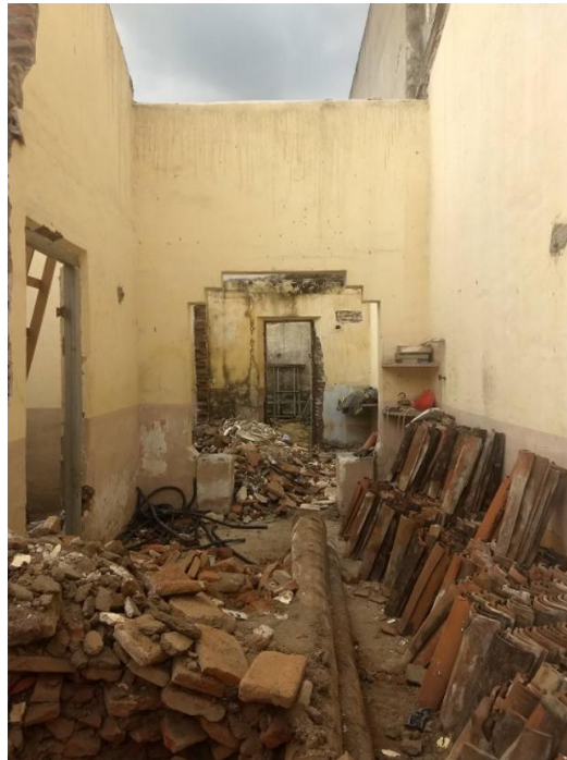
Fiscalização ET-Sobral (PARECER TÉCNICO nº 9/2020/ETS-CE/IPHAN-CE), vistoria realizada em 04/03/2020
