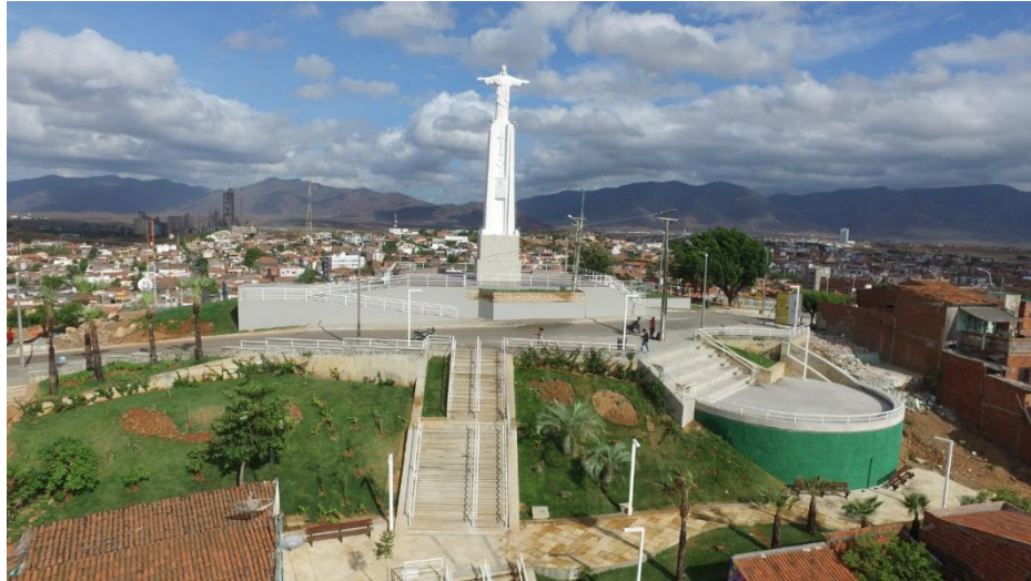
Figura 63: Foto da requalificação do Mirante do Cristo Redentor, em 2019
