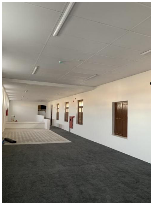
Figura 131: Piso elevado com carpete e rampa no corredor lateral do pavimento superior no Museu Dom José
