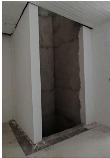
Figura 130: Caixa do elevador pronta para a instalação do equipamento
