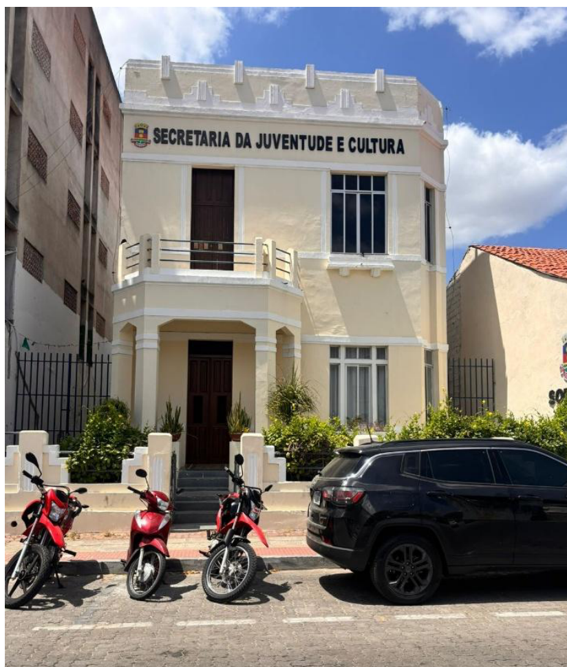
Figura 76: Fachada frontal do Palacete Chagas Barreto, atual Secretaria da Juventude e Cultura
