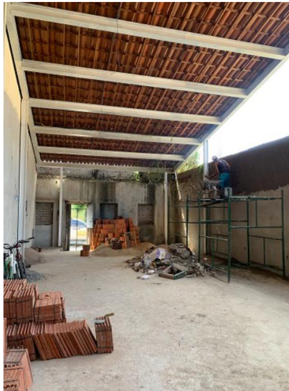
Figura 104: Vista interna com execução de serviços de cobertura, reboco e instalações elétricas sendo retomadas
