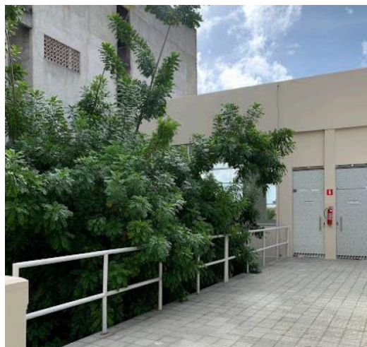
Figura 94: Área de ligação do pavimento superior do Palacete Chagas Barreto com a edificação anexa
