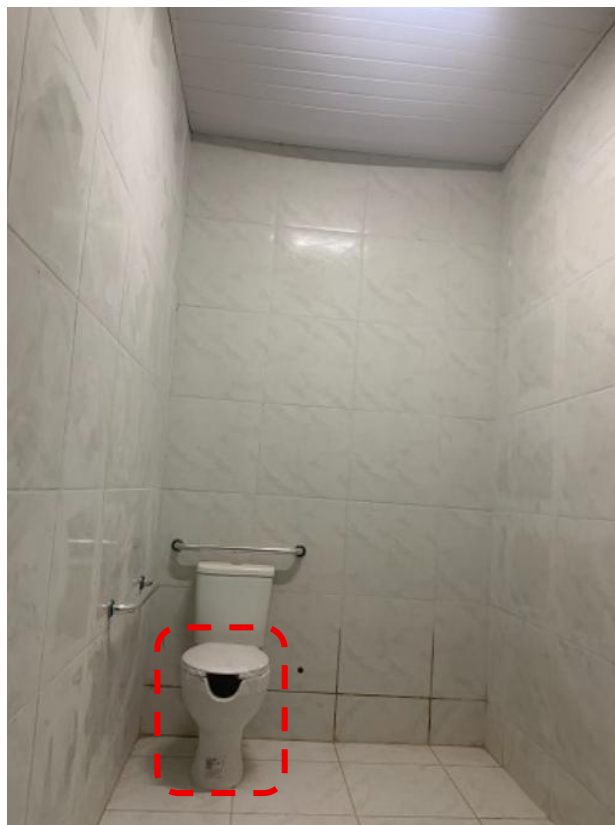
Figura 133: Execução de um dos sanitários acessíveis do Museu Dom José com bacia com abertura frontal
