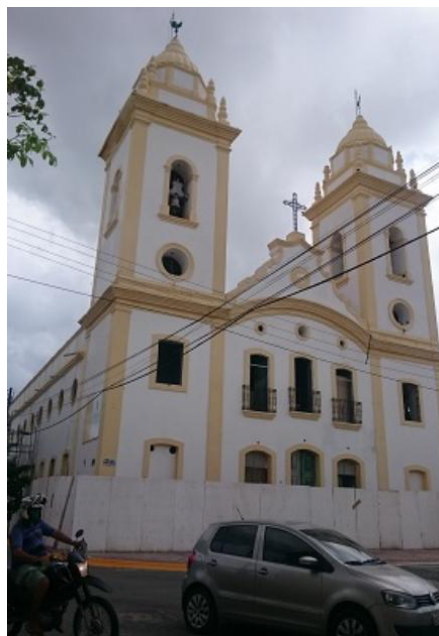
Figura 63 Fachada frontal e lateral da Igreja Menino Deus com pintura em caiação concluída.
