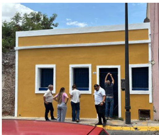
Figura 106: Vistoria em conjunto com a SEUMA e SEINFRA, fachada com pendências da reparação dos adornos, pintura e medidores
