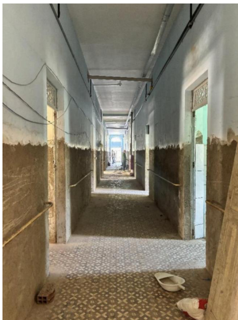
Figura 155: Execução de reboco no corredor do pavimento térreo do Abrigo SCJ
