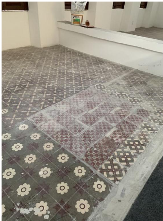
Figura 135: Ladrilhos hidráulicos com diferentes paginações e preenchimento com argamassa de pedaços faltantes das peças.
