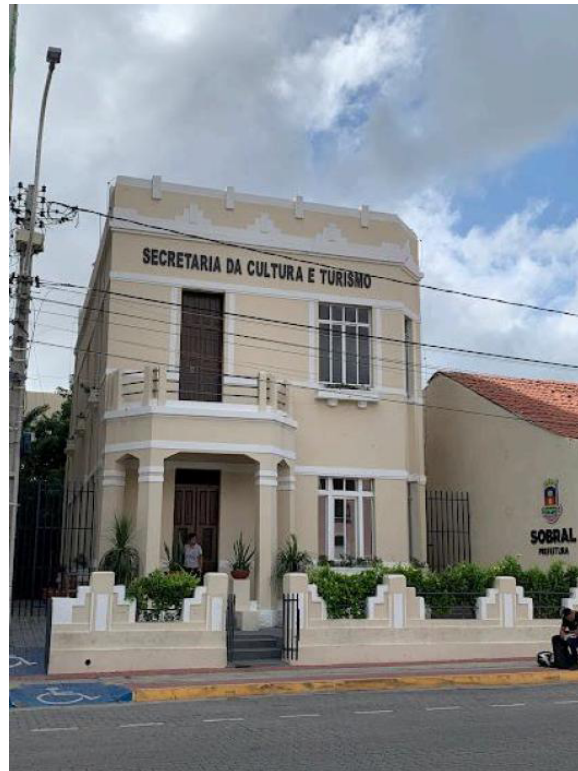
Fonte: Fiscalização ET-Sobral (PARECER TÉCNICO nº 2/2023/ETS-CE/IPHAN-CE), vistoria realizada em 31/01/2023
