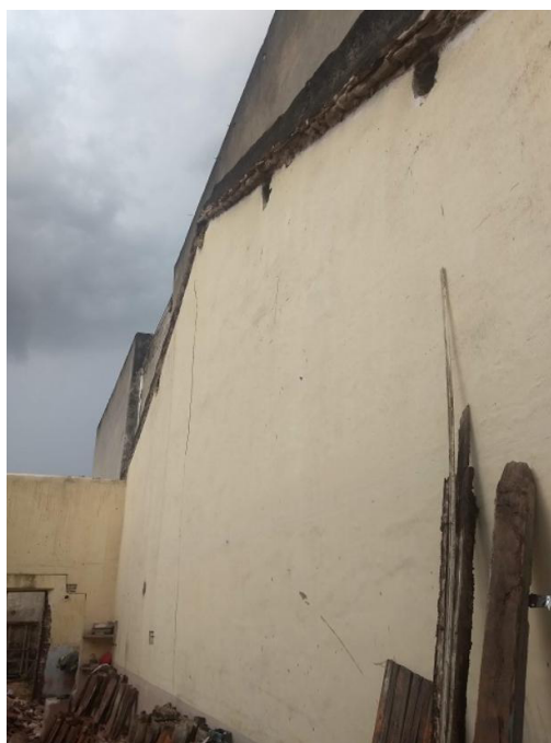
Figura 107: Vista do Teatro Apolo sem o madeiramento/coberta
