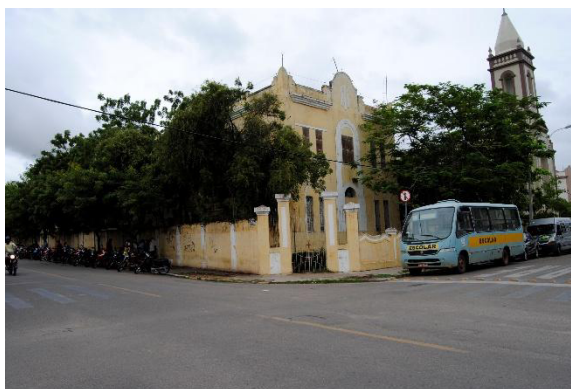
Figura 152: Fachada Sudeste antes da restauração.
