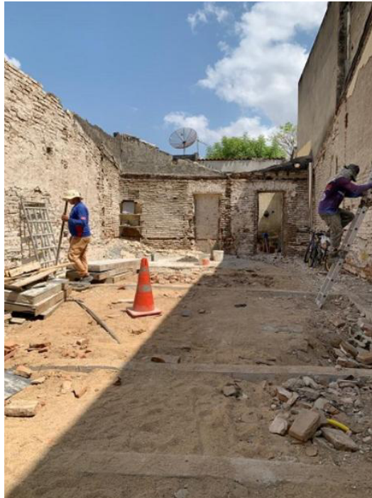
Fiscalização ET-Sobral (PARECER TÉCNICO nº 22/2023/ETS-CE/IPHAN-CE), vistoria realizada em set/2023
