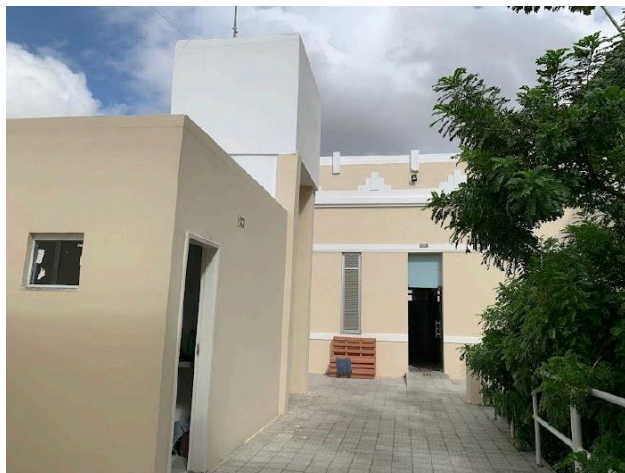
Figura 95: Área de ligação do pavimento superior do Palacete Chagas Barreto com a edificação anexa, com copa e caixa d'água
