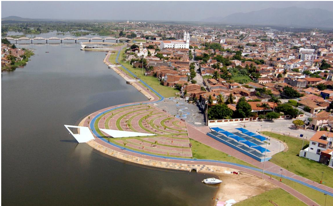
Figura 40: Urbanização da Margem Esquerda do Rio Acaraú em Sobral.
