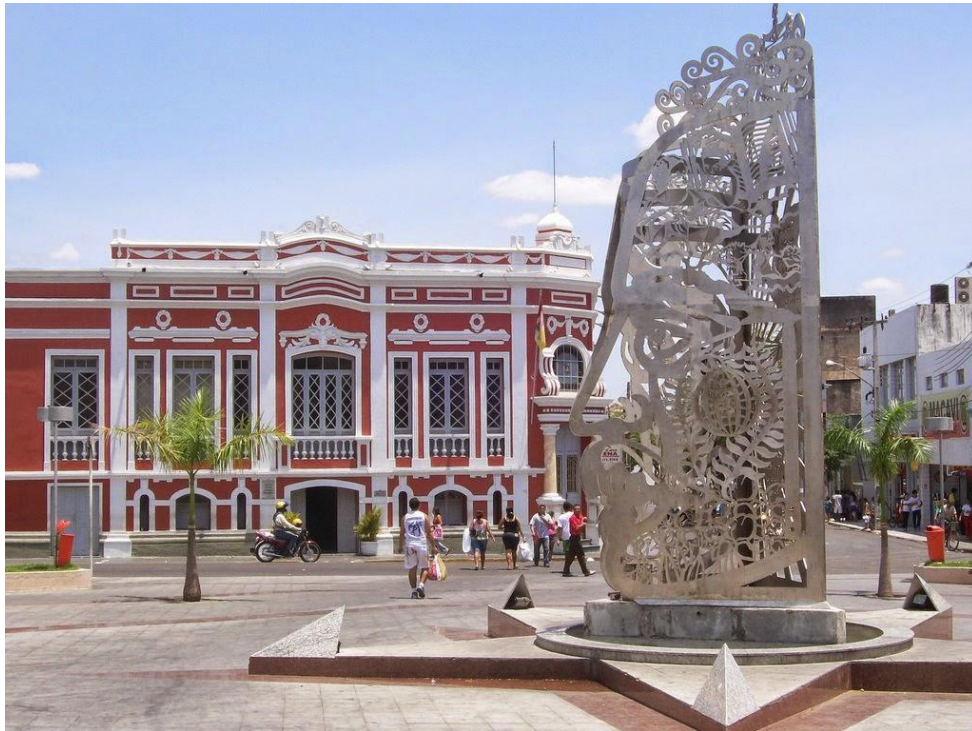
Figura 47: Reforma do Teatro São João, em Sobral.
