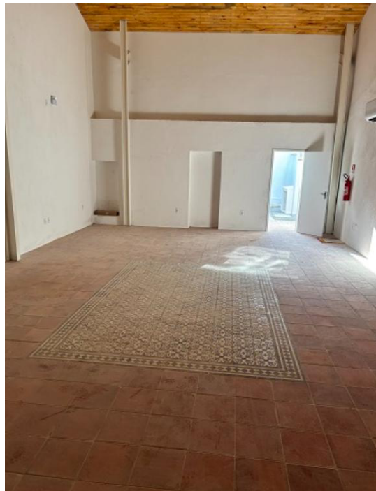
Fiscalização ET-Sobral (PARECER TÉCNICO nº 2/2023/ETS-CE/IPHAN-CE), vistoria realizada em 31/01/2023
