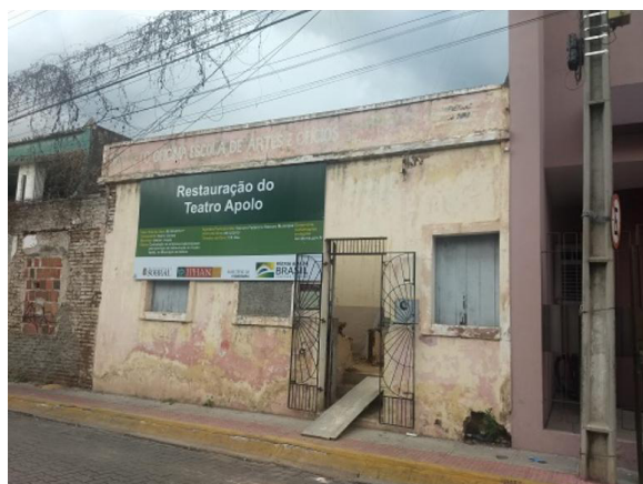
Figura 105: Vista da fachada frontal do Teatro Apolo
