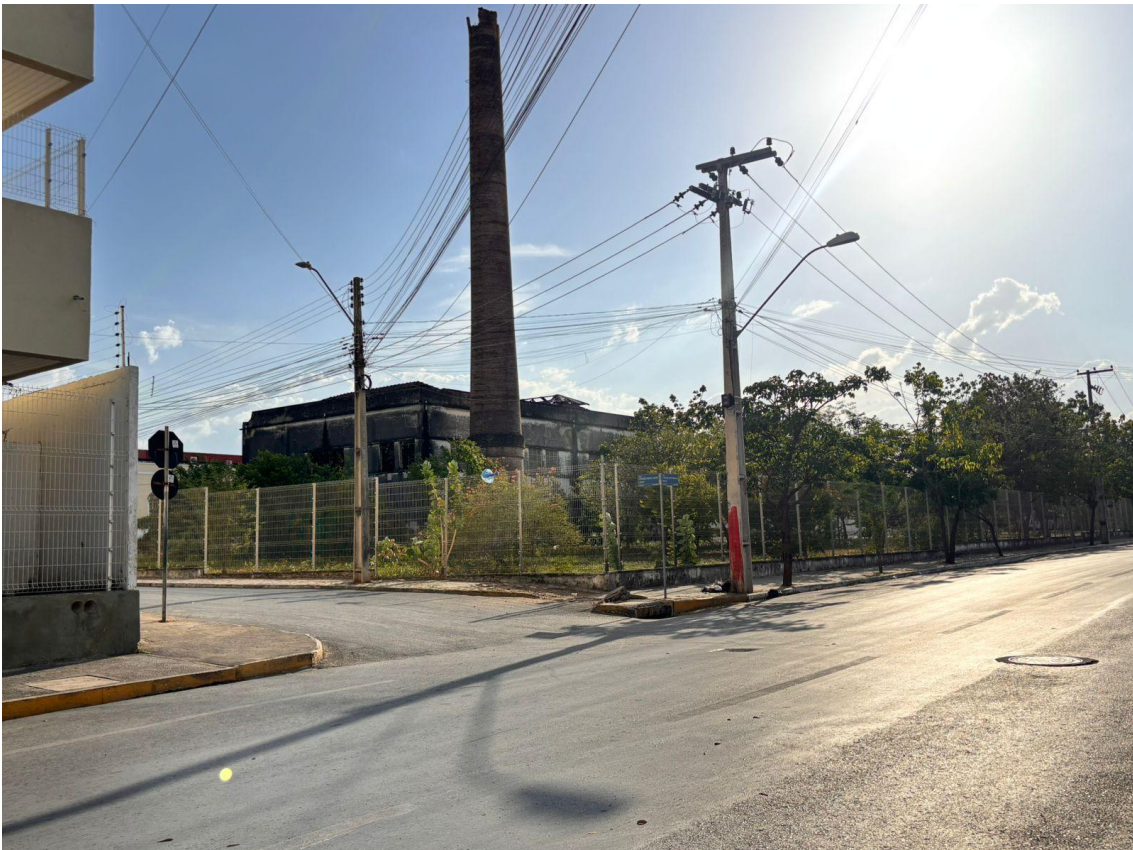
Figura 163: Fábrica de Tecidos de Sobral, com ênfase na chaminé existente.
