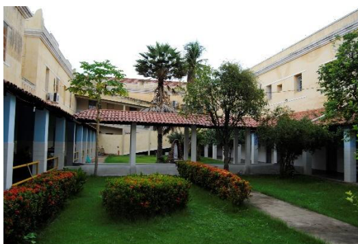
Figura 156: Pátio entre blocos do Abrigo SCJ antes da restauração
