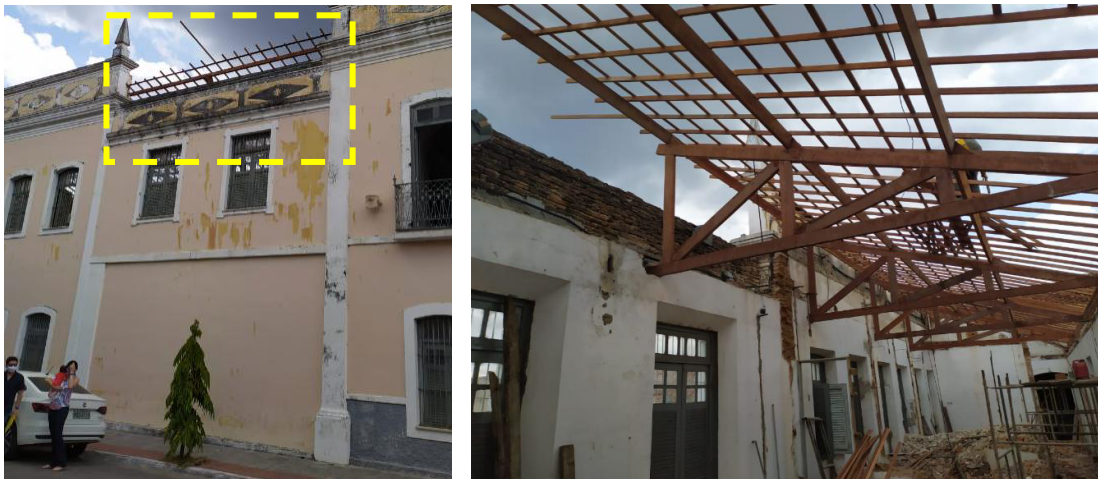
Figura 124: Imagem externa e interna da cobertura aparente ultrapassando a platibanda na fachada do Museu Dom José
