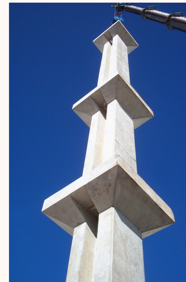
Figura 08-05.2.1 – Pilar pré-fabricado com seção "H"
