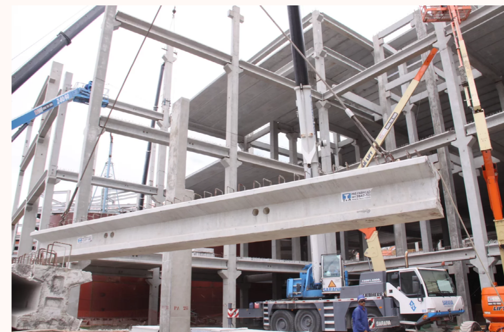
Figura 12-05.2.1 – Içamento de viga protendida pré-fabricada com furação
