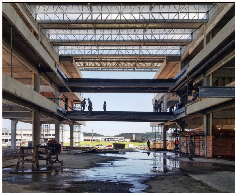
Figura 04-04.2. – Perspectiva interna do Ágora Tech Park durante a construção
