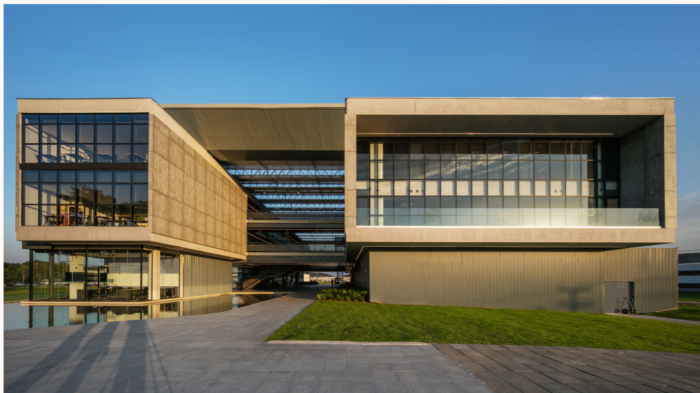
Figura 01-04.2 – Fachada Norte do Ágora Tech Park
