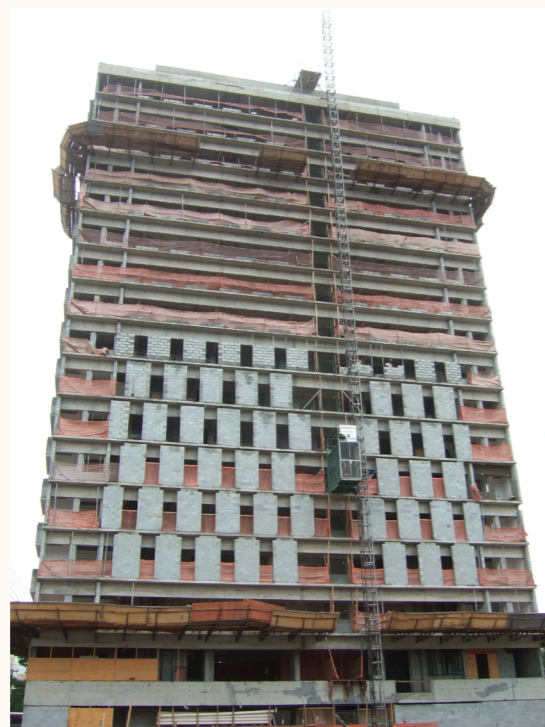
Figura 06-04.1. – Fachada torre Jardim Edite em construção
