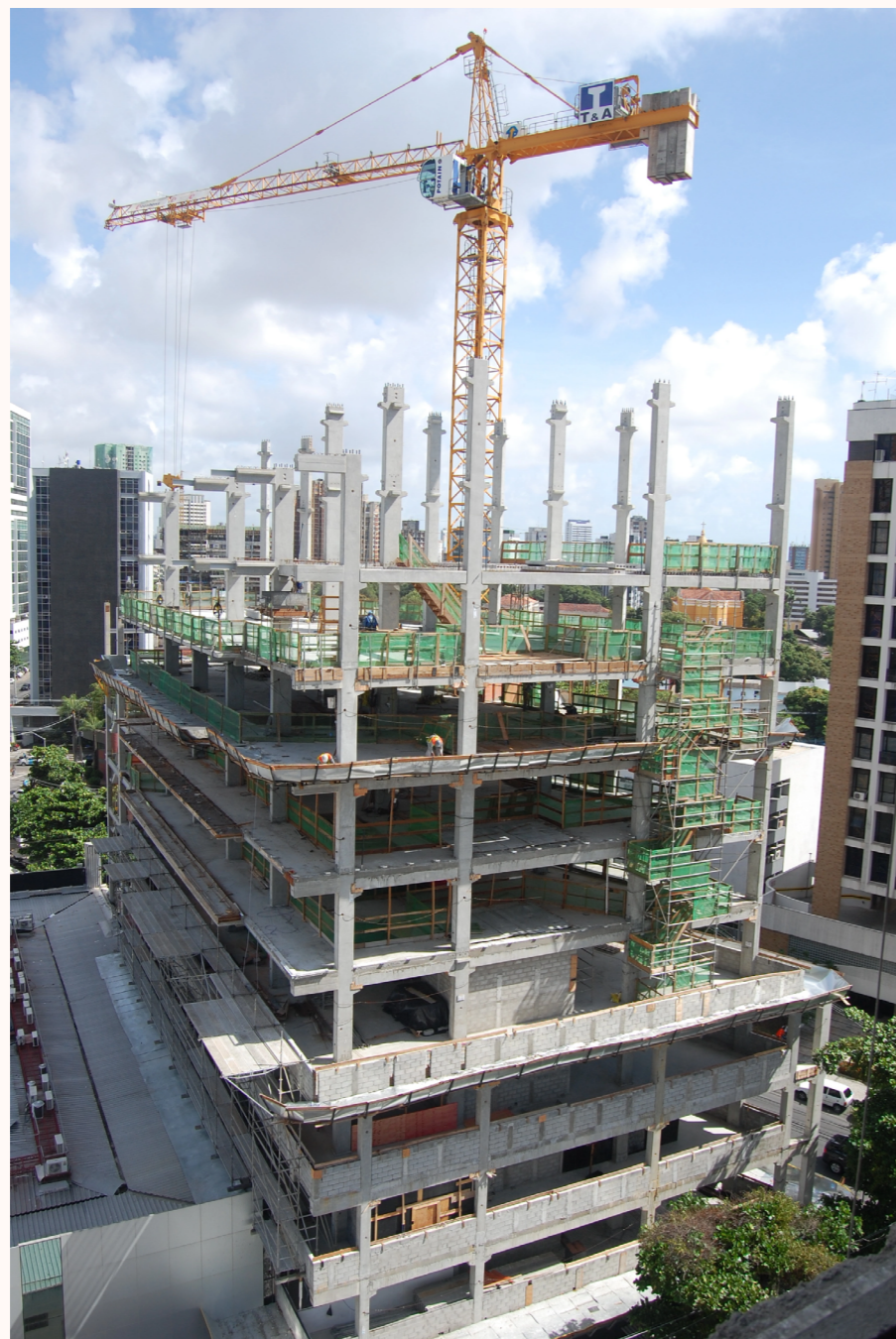
Figura F6-03.4 – Construção do Hospital Ilha do Leite da Hapvida (Recife, PE)
