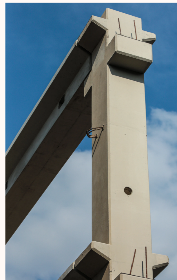
Figura 07-05.2.1 – Pilar pré-fabricado com quatro consoles
