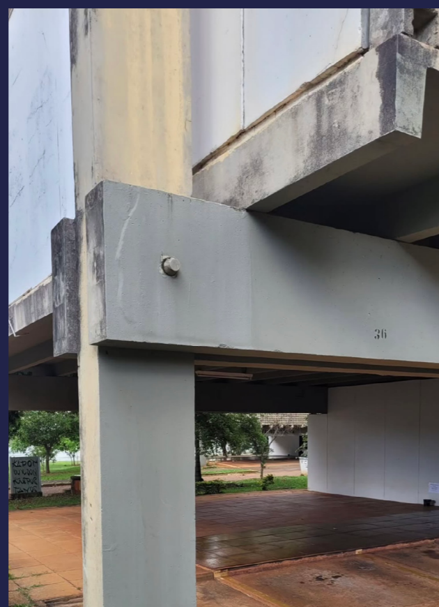
Figura 03-03.1 – Fixação e travamento das vigas
