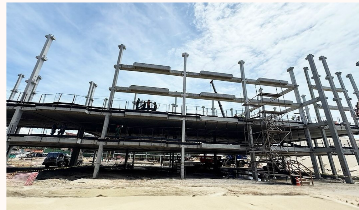
Figura 09-03.4 – Montagem da estrutura pré-fabricada do Ohana Beach Park Resort
