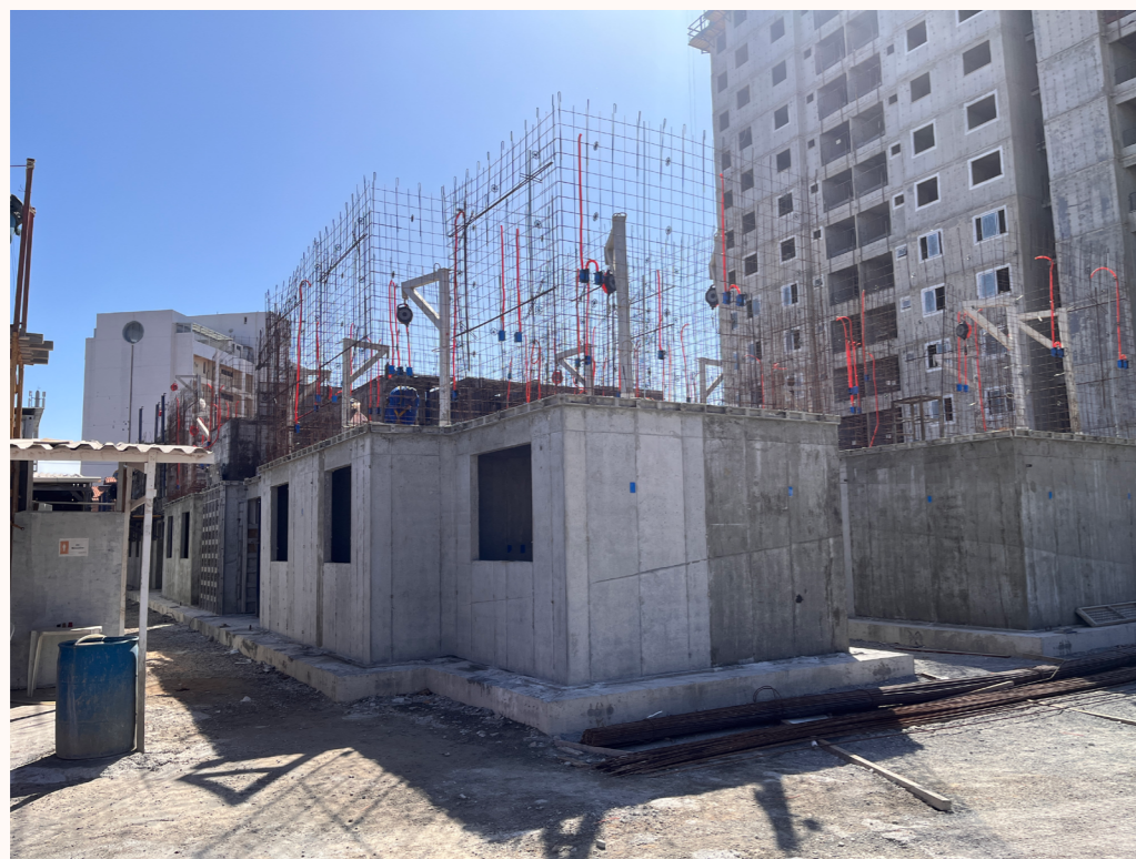
Figura 03-03.4 – Preparação de conduítes para montagem de formas e concretagem das paredes
