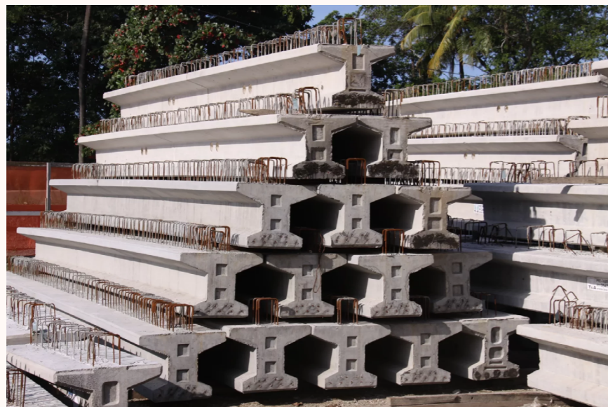
Figura 10-05.2.1 – Vigas protendidas pré-fabricadas armazenadas em canteiro de obras
