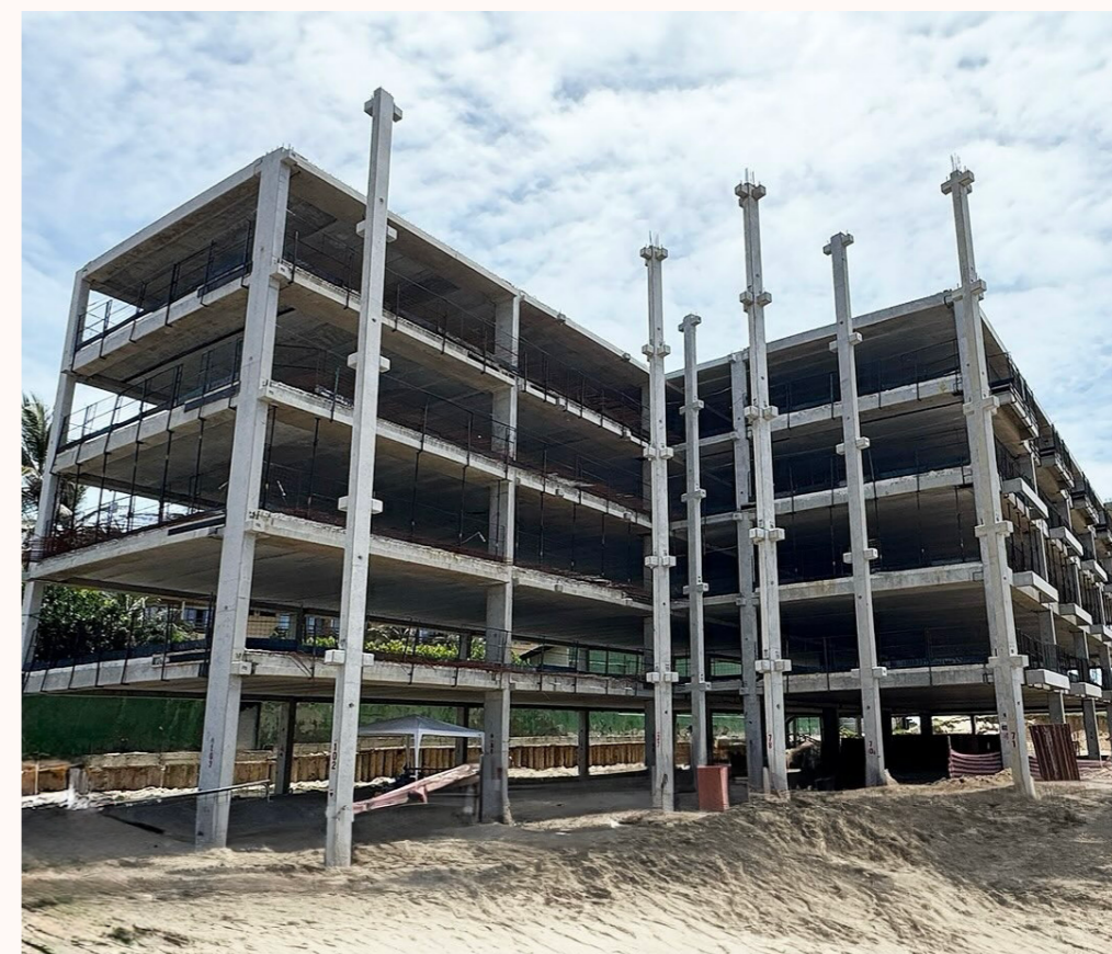
Figura 10-03.4 – Estrutura pré-fabricada do Ohana Beach Park Resort
