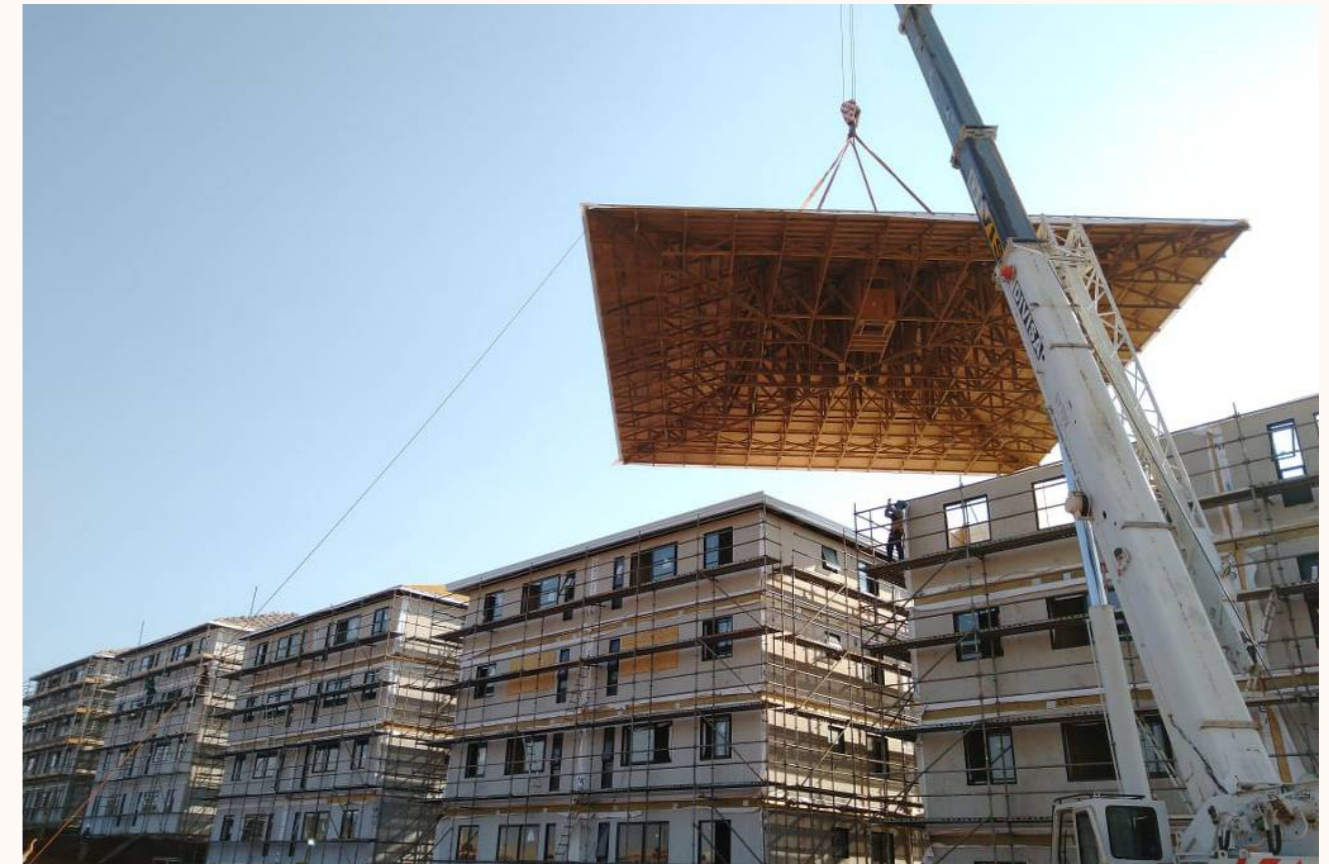
Figura 02-03.4 – Montagem de um empreendimento em "light wood framing"
