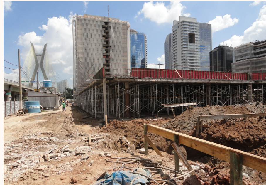
Figura 05-04.1. – Montagem das formas da laje nervurada de uma das lâminas horizontais
