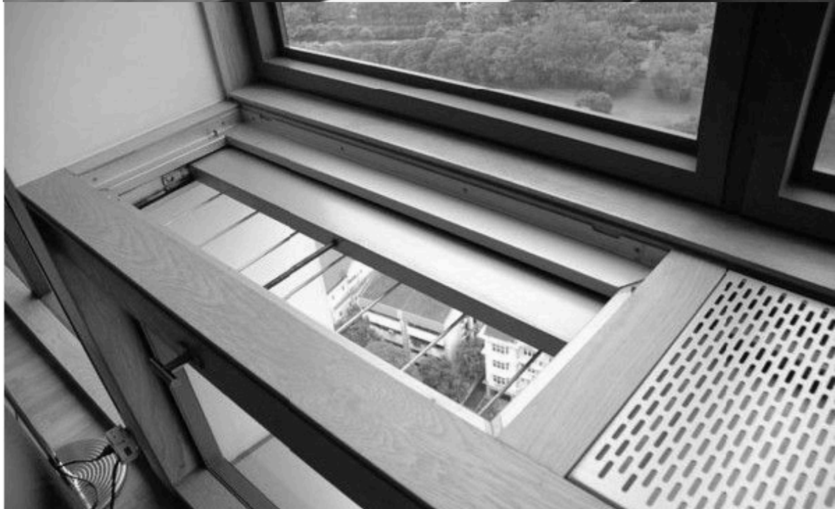
Figura 47 e 48 - Esquematização do funcionamento da esquadria "monsoon windows" Fonte: Woha, 2025.
