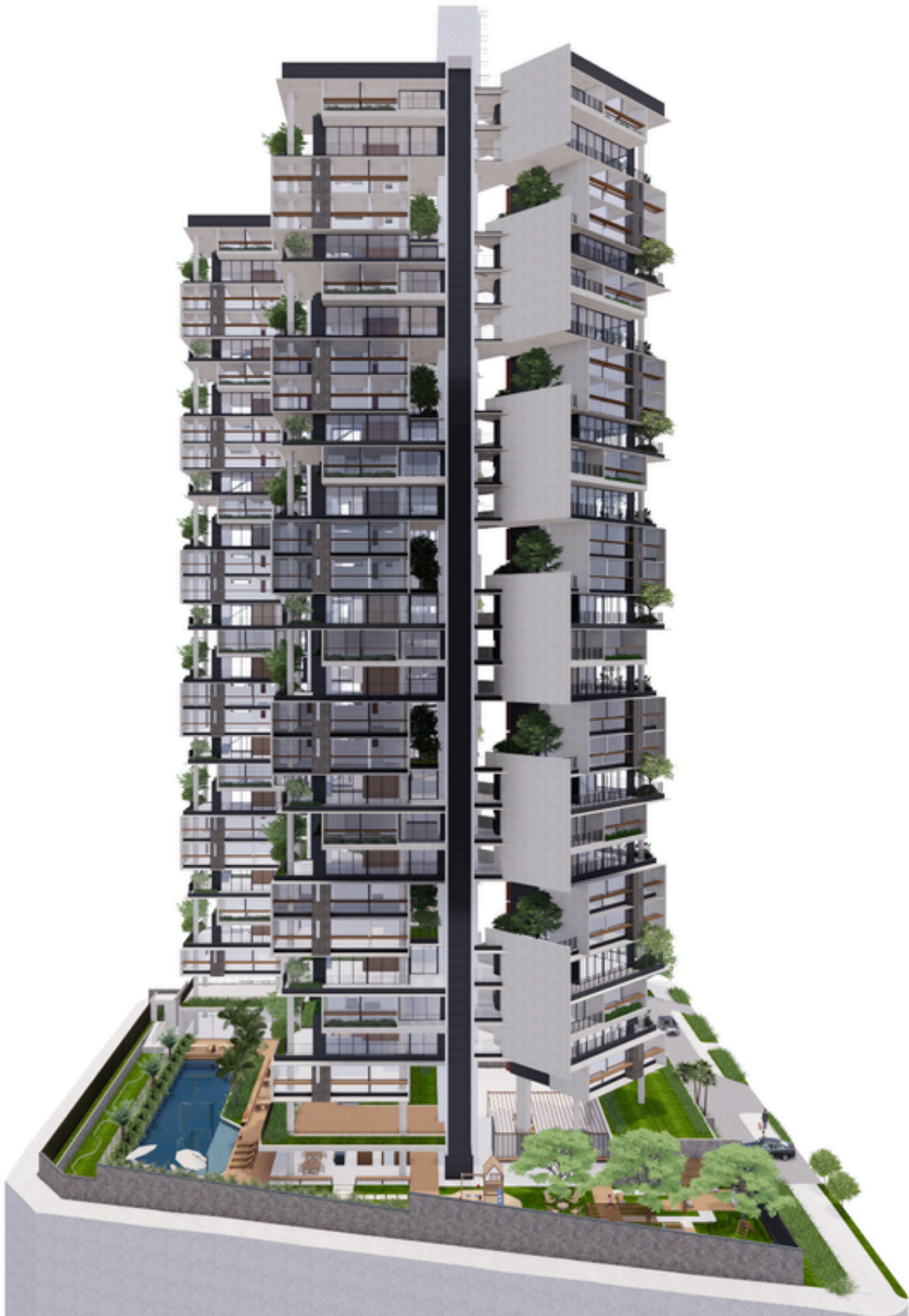
Figura 85 - Vista fachada Leste Imagem elaborada pelo autor
