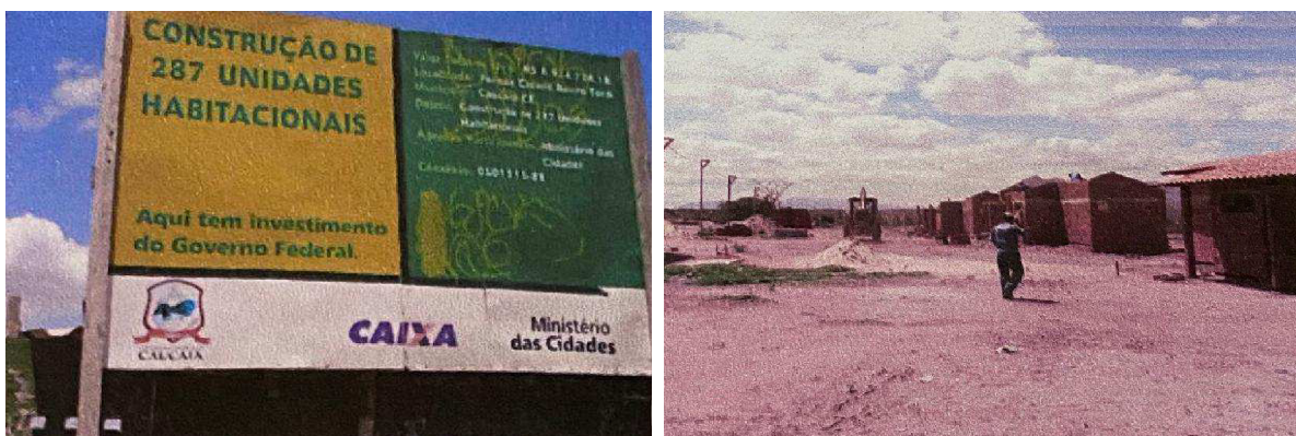
Figuras 46 e 47 – Desenvolvimento das obras de reassentamento
