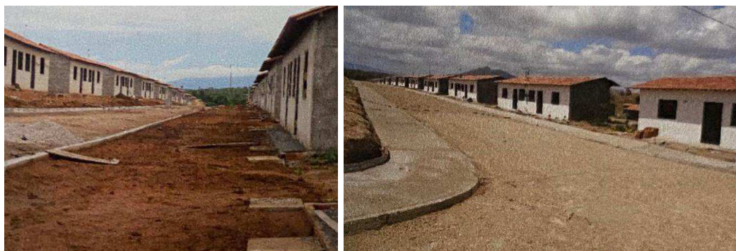
Figuras 48 e 49 – Desenvolvimento das obras de reassentamento
