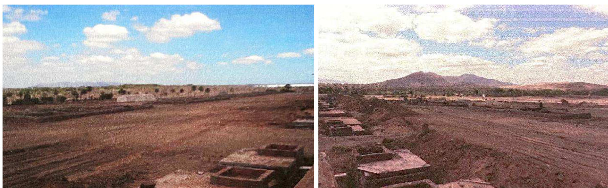
Figuras 44 e 45 – Início das obras de reassentamento
