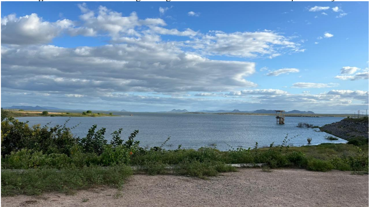
Figura 19 – Vista da Barragem Engenheiro Armando Ribeiro Gonçalves - Itajá
