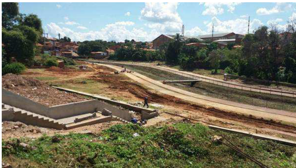
Figura 28: Execução das obras do projeto de Requalificação da Vila da Paz, em 2013.
