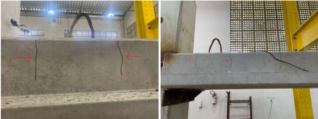
(a) Face lateral da viga - lado esquerdo
