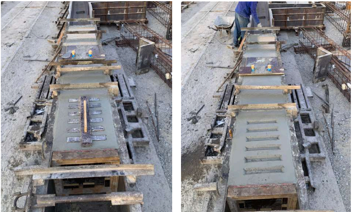
(b) Concretagem do pilar
