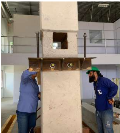
(c) Fixação dos consolos;
