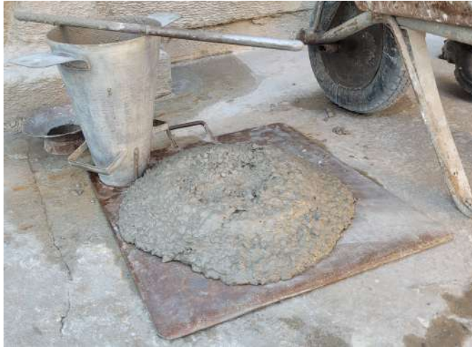
(a) Teste de slump
