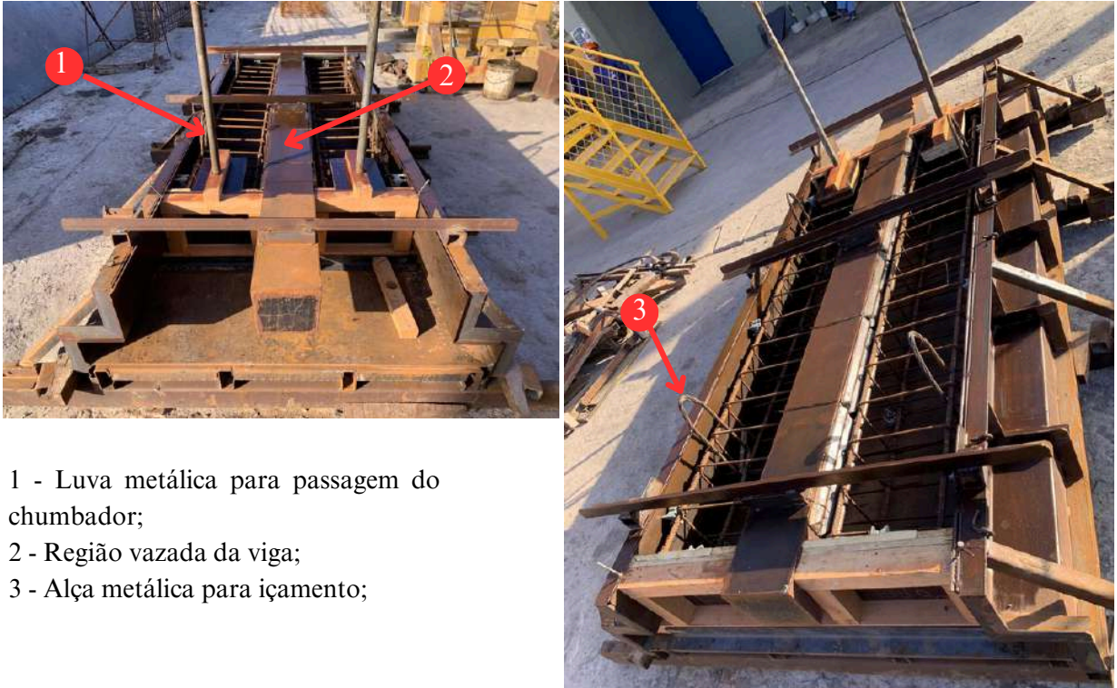
(a) Fôrma e armadura da viga
