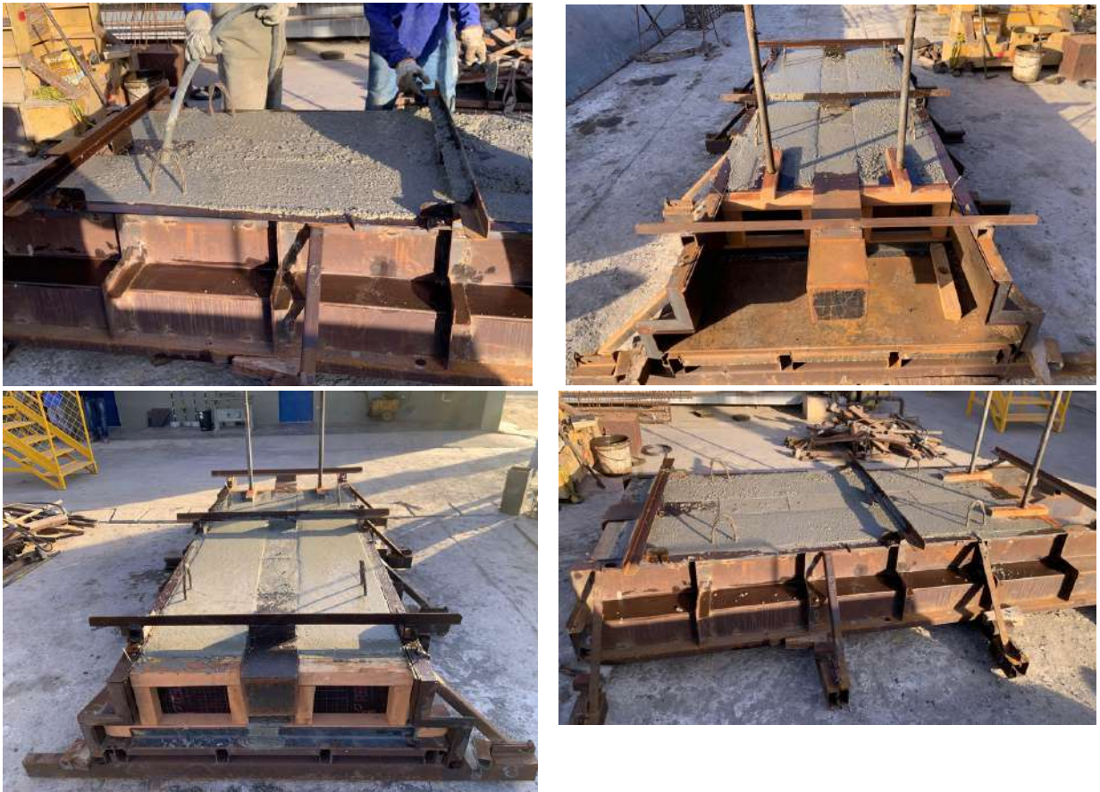
(a) Concretagem das vigas
