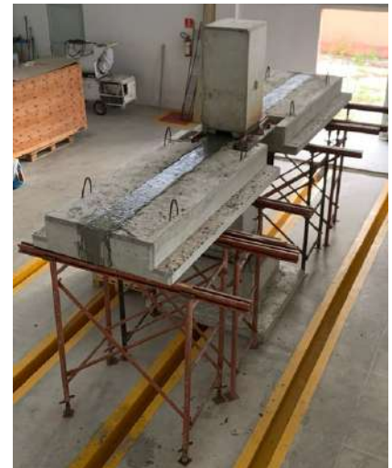
(g) Preenchimento total da abertura da viga e parcial da abertura do pilar com graute.
