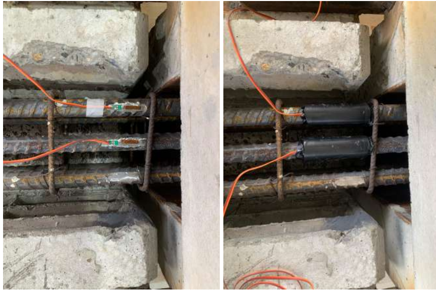
(a) Instalação dos strain gauges (b) Proteção dos strain gauges
