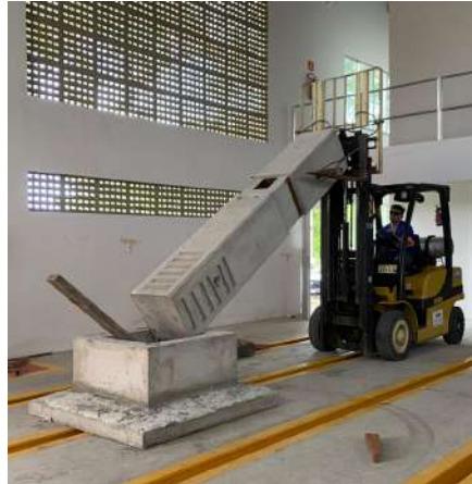
(b) Encaixe do pilar no interior da sapata;
