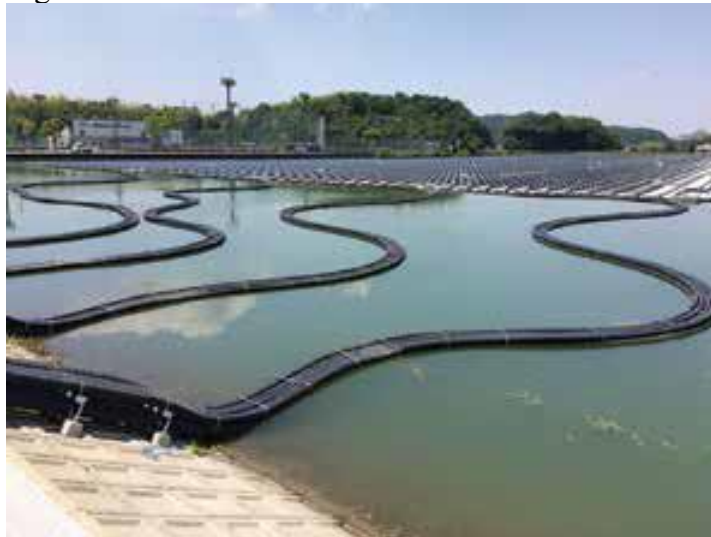
Figura 15 – Percurso dos cabos elétricos até o solo
