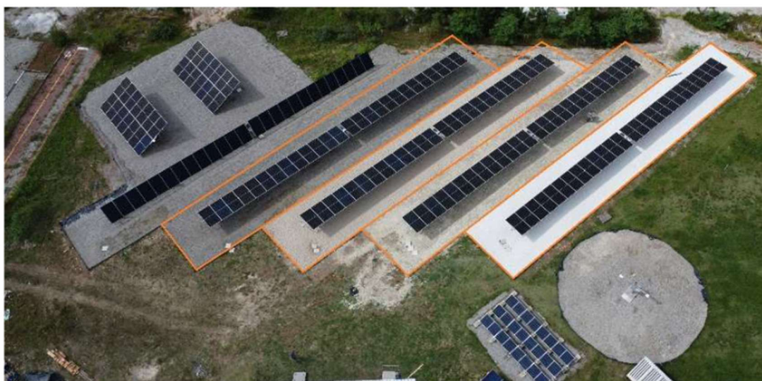
Figura 3 – Disposição de Materiais no solo da usina.
