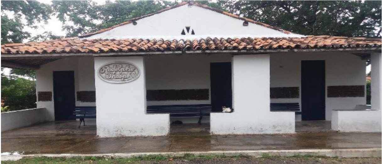
Figura 19 - Casa de Rodolfo Teófilo, no bairro Pajuçara
