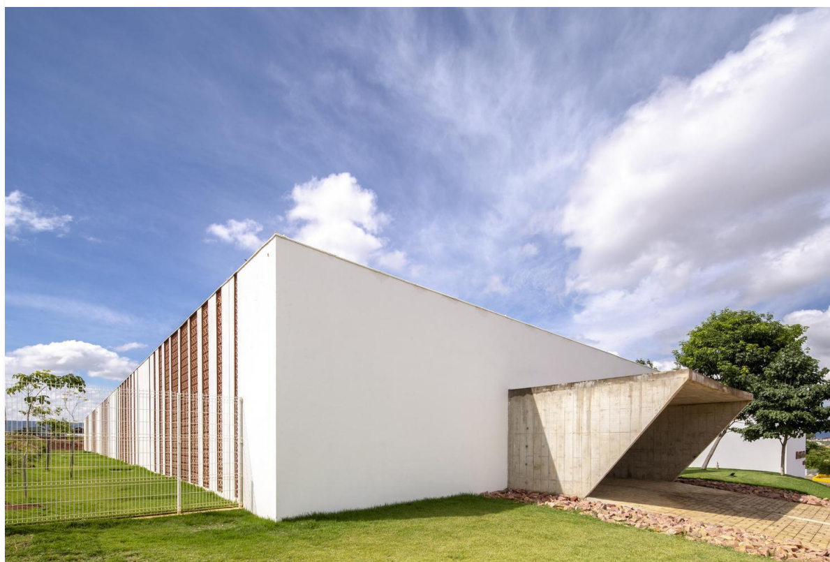
Figura 3.17 - O volume criado pelas paredes do Juizado Cível e Criminal. Fonte: https://www.archdaily.com.br/br/916243/juizado-especial-civel-e-criminal-de-unileao-lins-arquitetos-associados?ad_medium=office_landing&ad_name=article
