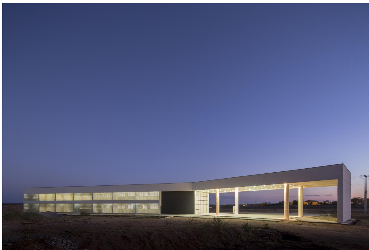
Figura 3.28 - A fachada norte do Bloco Administrativo. Fonte: https://www.archdaily.com.br/br/784398/ufc-crateus-rede-arquitetos?ad_medium=office_landing&ad_name=article
