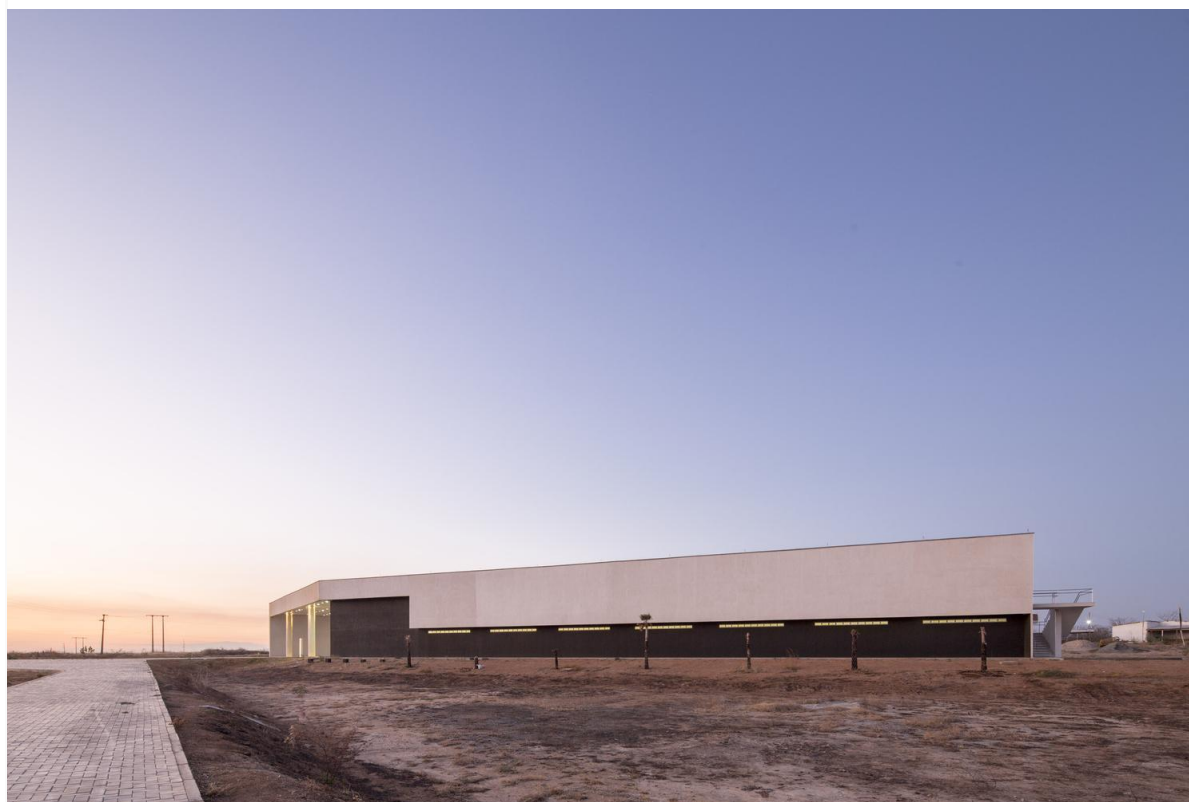
Figura 3.26 - A fachada opaca do Bloco Administrativo. Fonte: https://www.archdaily.com.br/br/784398/ufc-crateus-rede-arquitetos?ad_medium=office_landing&ad_name=article
