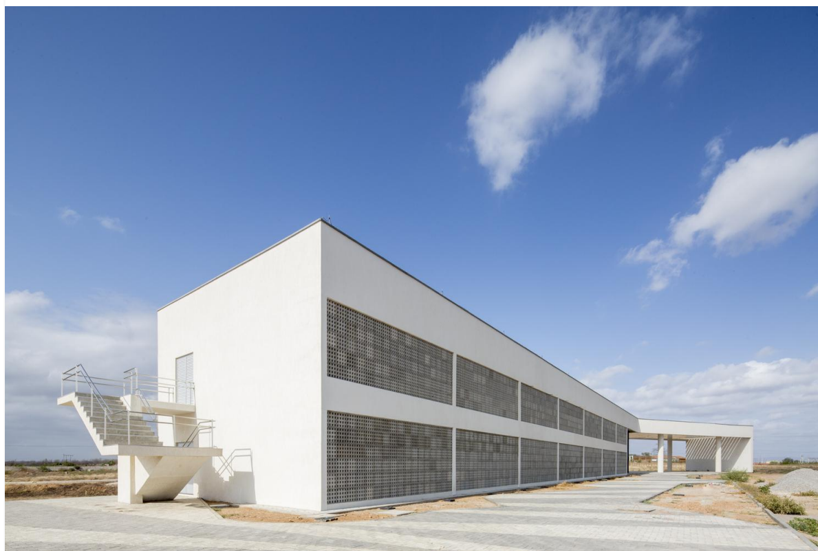
Figura 3.27 - A fachada leste do Bloco Administrativo. Fonte: https://www.archdaily.com.br/br/784398/ufc-crateus-rede-arquitetos?ad_medium=office_landing&ad_name=article
