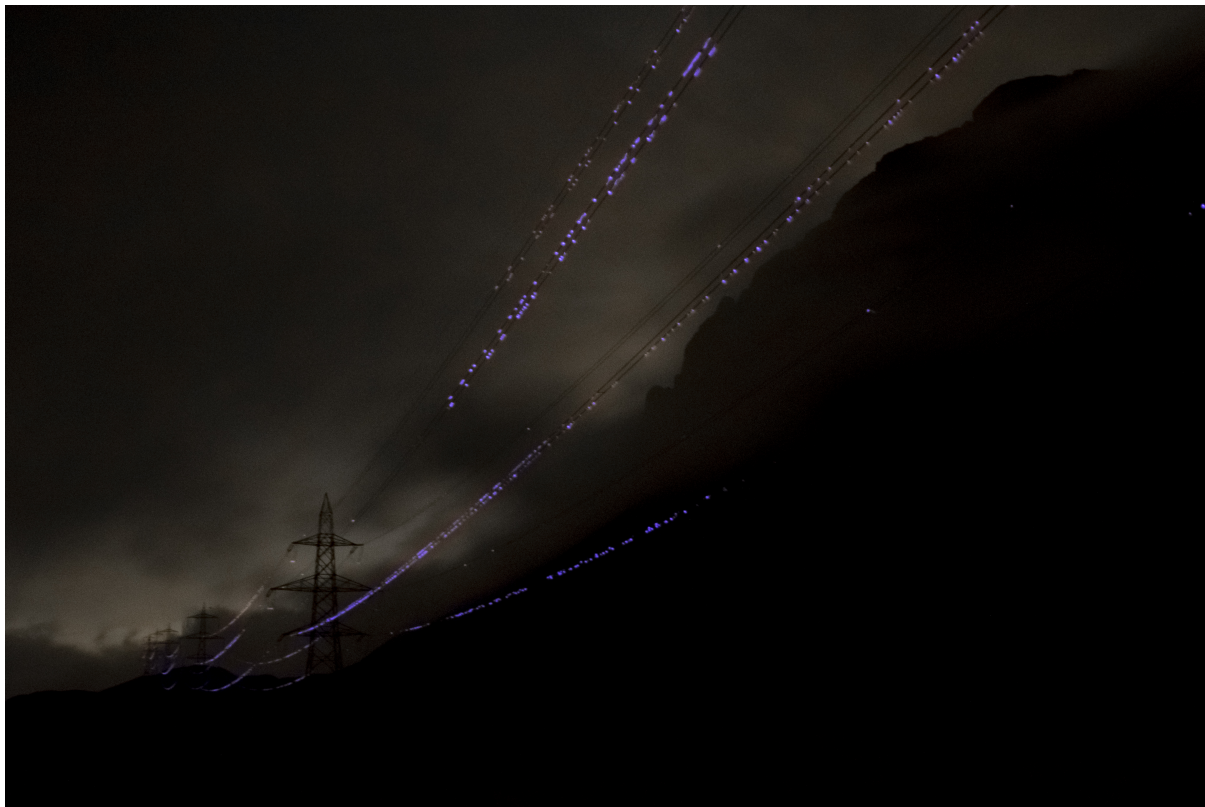
Figura 9 – Efeito Corona em linha de transmissão aérea suíça de 380 kV
