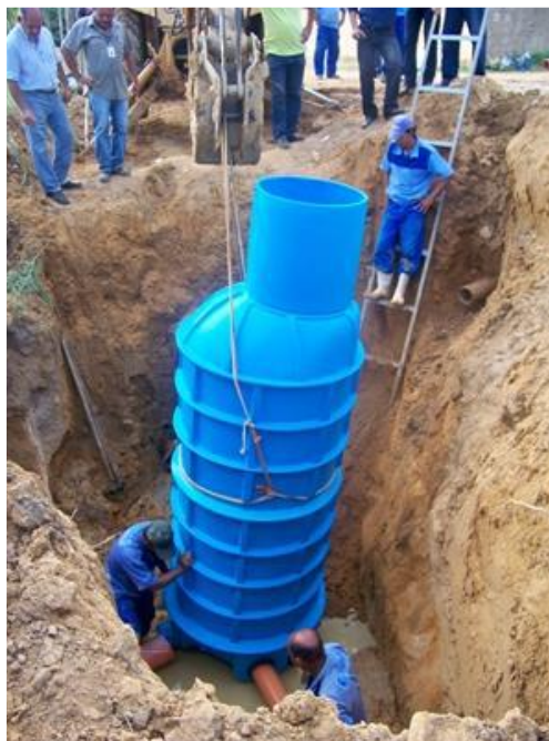
Figura 6 – Tubo de inspeção e limpeza em material flexível.
