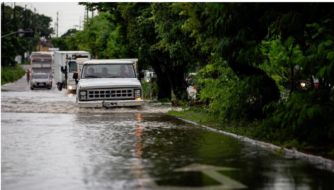
Figura 2 - Alagamento causado por uma chuva intensa em fevereiro de 2025 em Fortaleza.
