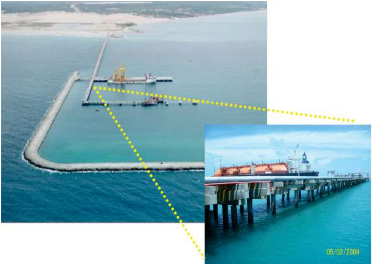
Figura 20 - Vista aérea do Terminal Portuário do Pecém.
