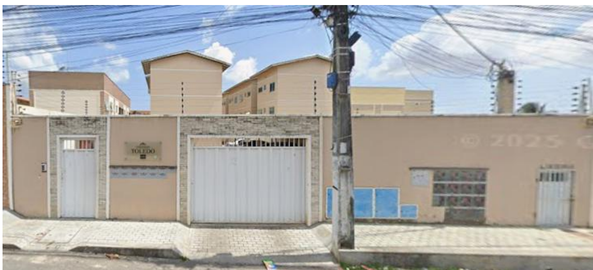
Figura 10 - Fachada da edificação objeto deste estudo
