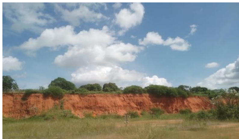
Figura 7 - Talude de corte presente na jazida
