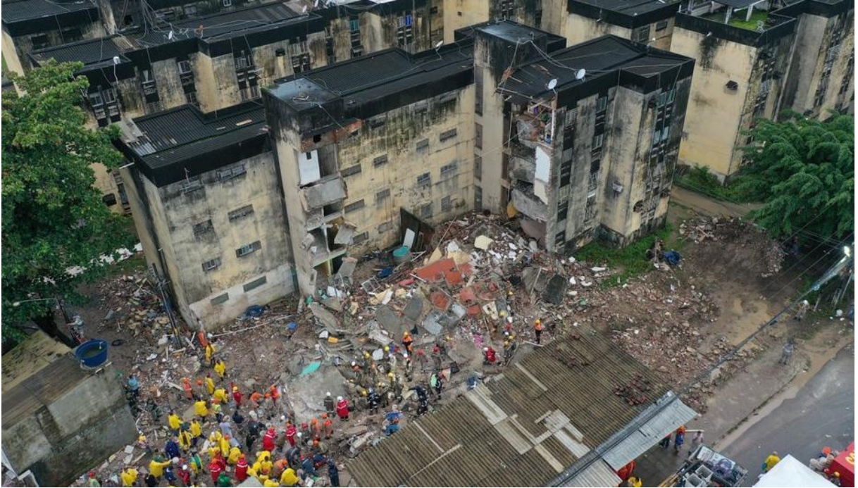
Figura 03: Desmoronamento parcial de um prédio, em Recife/PE.
