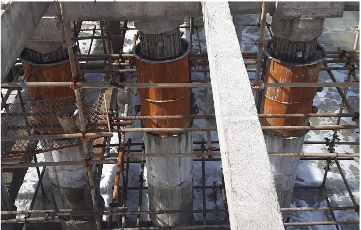
Figura 40: Aplicação de concreto autoadensável.
