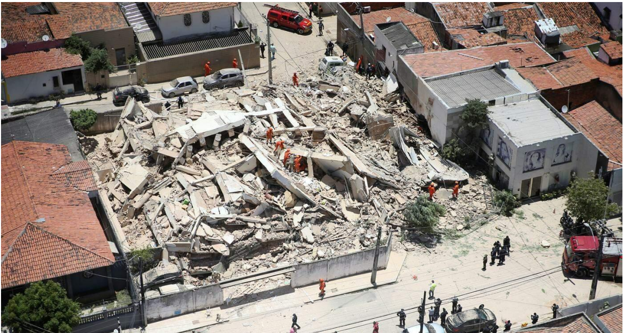
Figura 02: Desabamento do edifício Andrea, em Fortaleza/CE.
