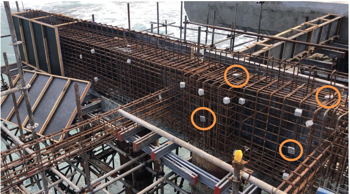
Figura 38: Instalação dos ânodos de sacrifício (destacados em laranja).
