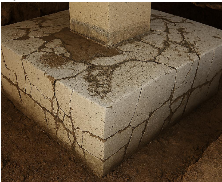
Figura 18: Fatores condicionantes do RAA deletéria.
