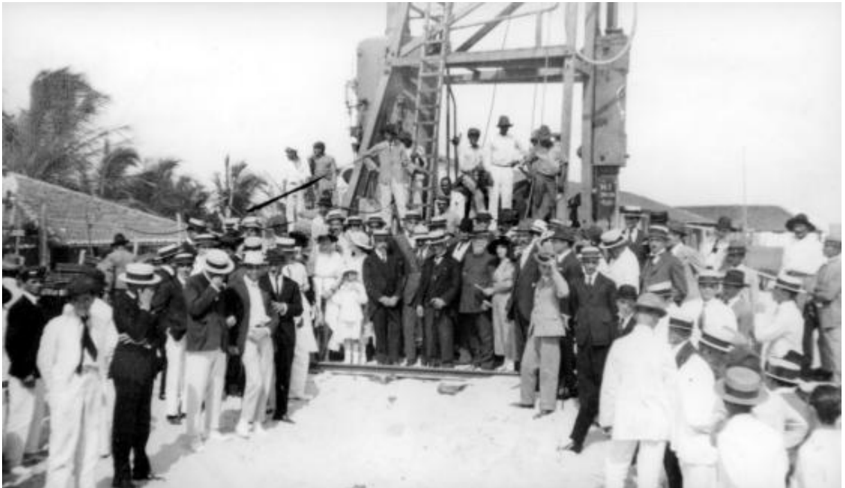
Figura 21: Inserção da primeira estaca da Ponte dos Ingleses.
