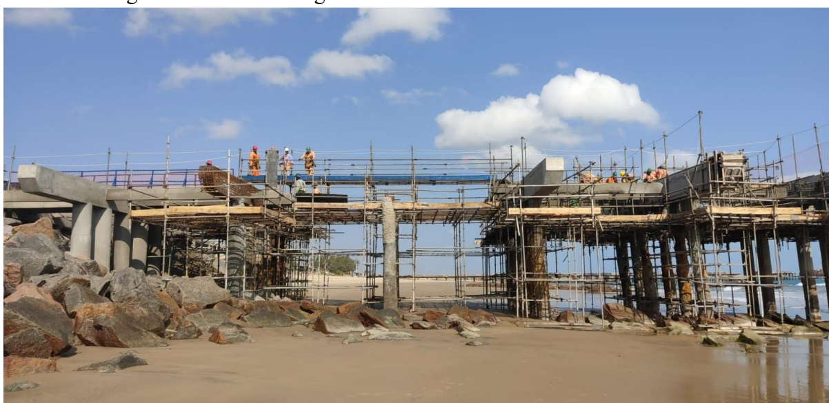
Figuras 31 e 32: Montagem da acessibilidade.
