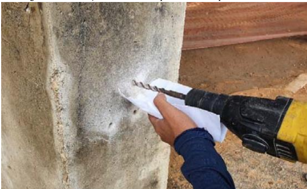
Figura 27: Perfuração com furadeira para análise do pó do concreto.
