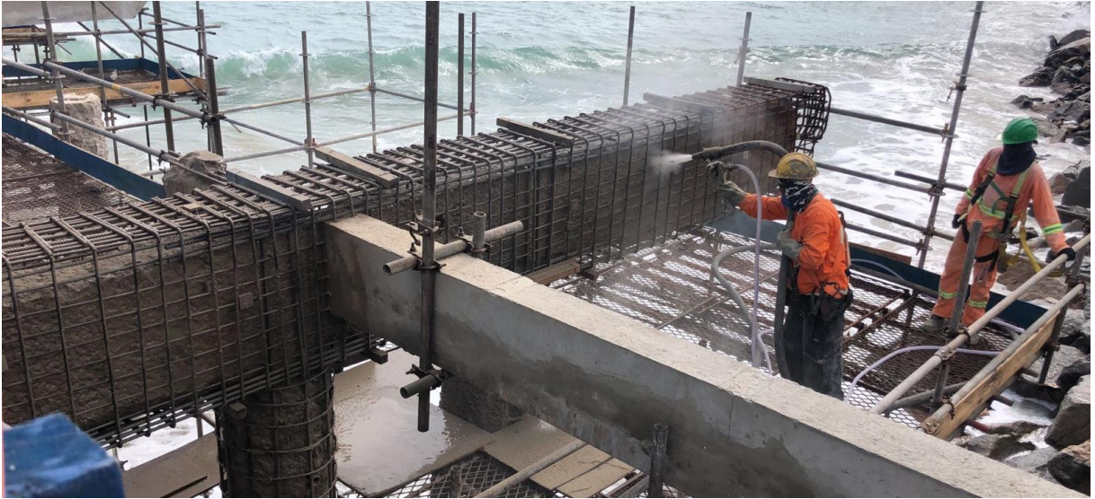
Figura 35: Hidrojateamento para limpeza da superfície.
