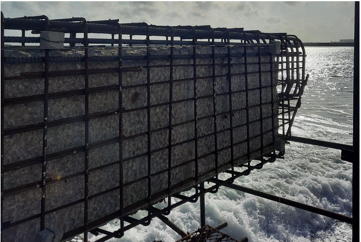
Figura 36: Recomposição de armadura.
