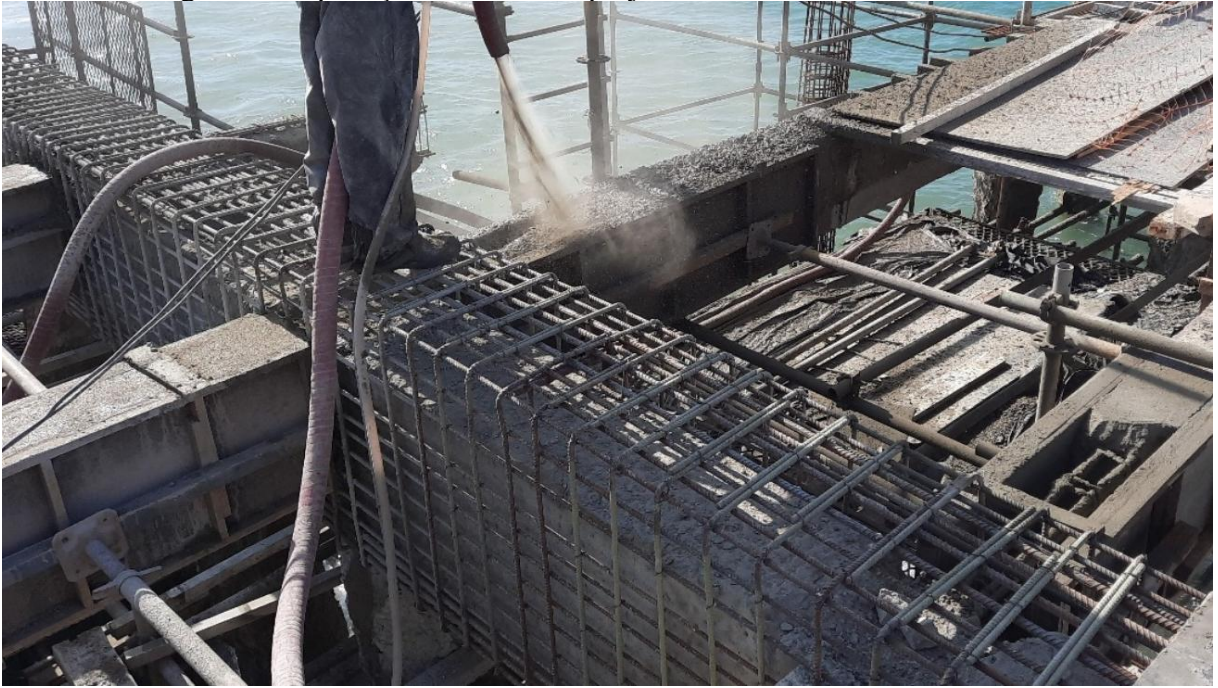
Figura 39: Aplicação de concreto projetado via seca.
