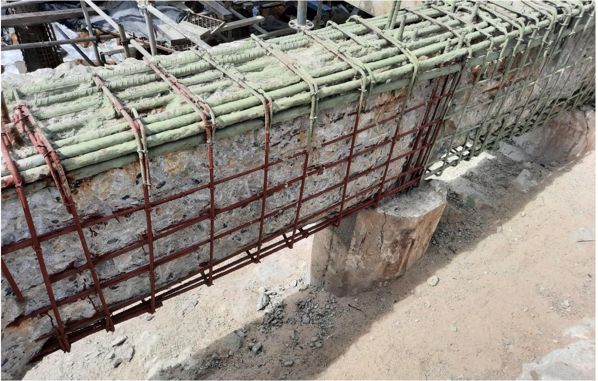
Figura 37: Pintura protetora com inibidor de corrosão.
