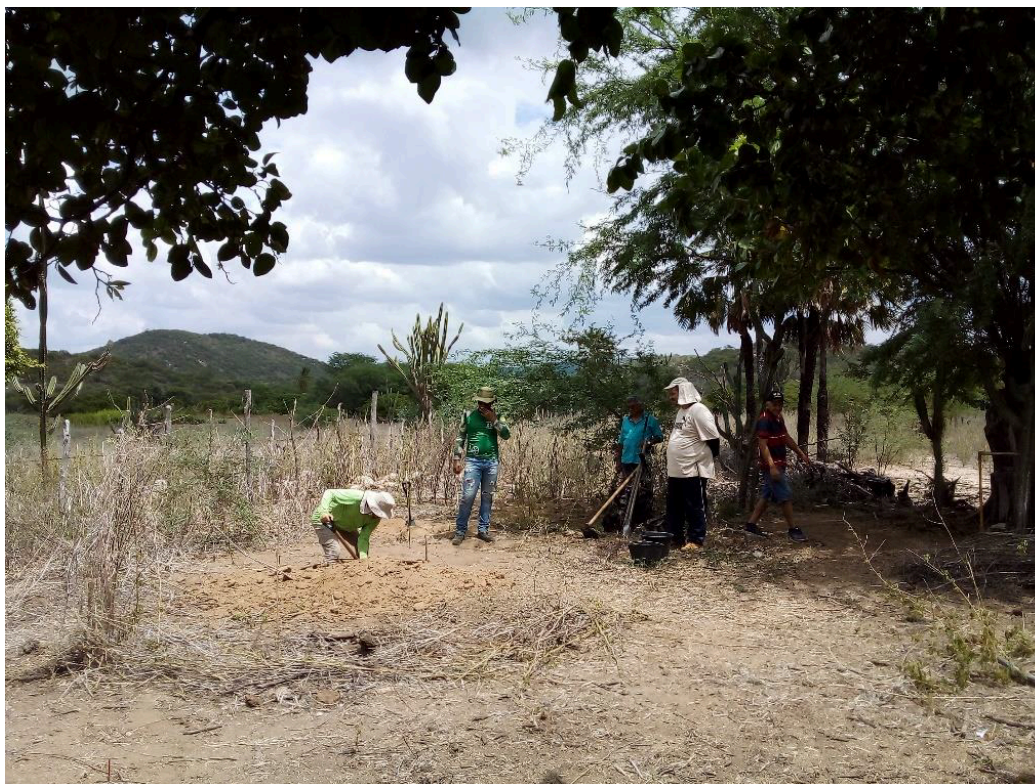
Fig.14 - Limpeza geral da área a ser escavada.
