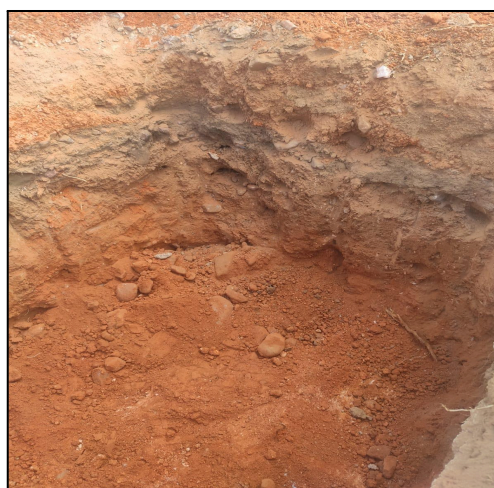
Figura 7 - Escavação solo terreno na cidade de Crateús - CE
