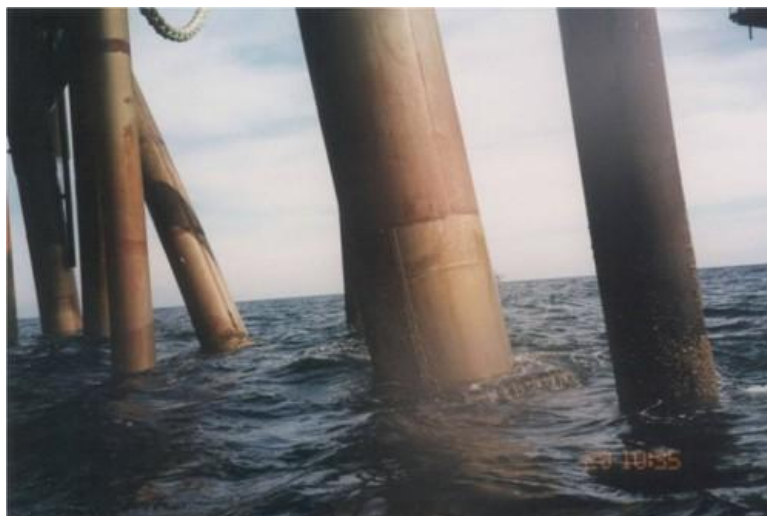
Figura 6 – CuNi 90/10 aplicado em regiões de respingo próximo aos pés da plataforma.
