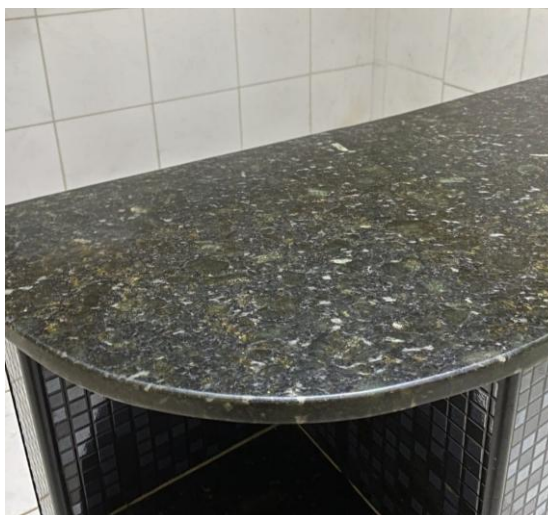
Figura 3 – Tampo de bancada instalado
