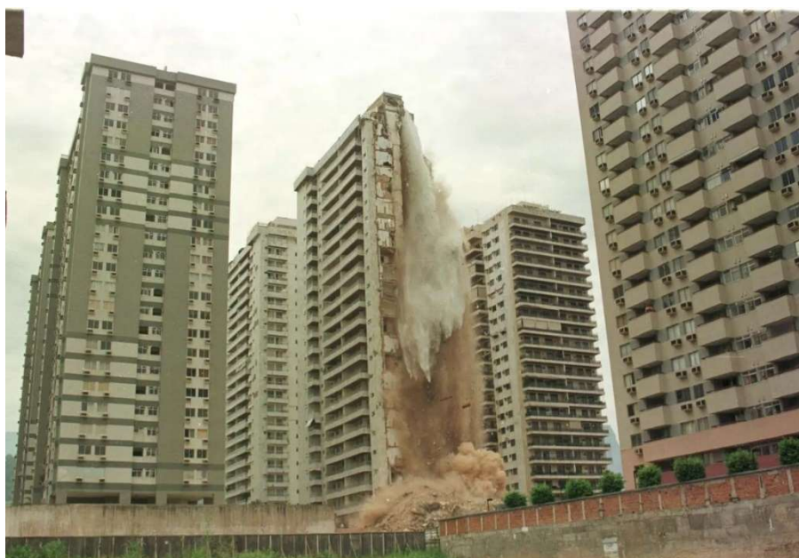
Figura 2 - Desabamento do edifício Palace II em 1998
