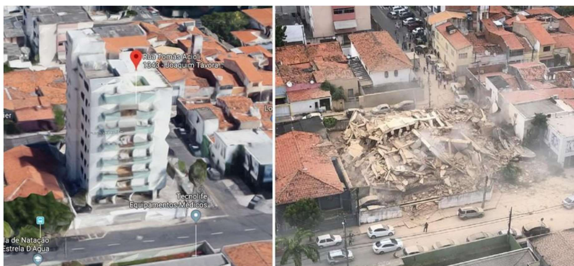
Figura 3 - Edifício Andrea antes e após o desabamento em 2019
