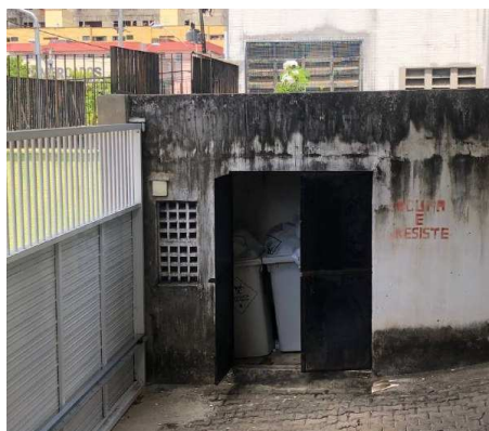
Figura 19: Local de disposição final e coleta externa.
