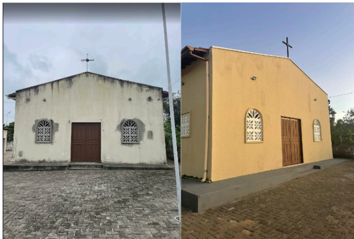
Figura 17 - Antes e depois da reforma da Igreja Nossa Senhora da Saúde
