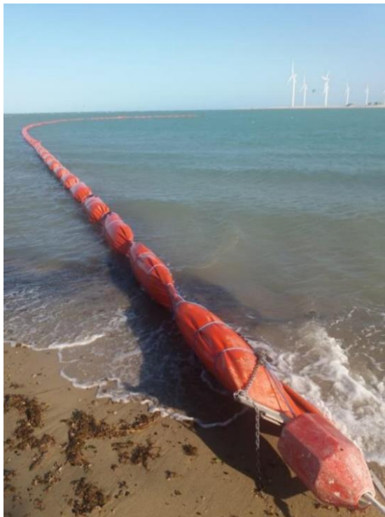
Figura 7 - Barreira de Contenção instalada na foz do Rio Jaguaribe/Fortim colocada segundo indicação das cartas SAO (Sensibilidade Ambiental ao Óleo).
