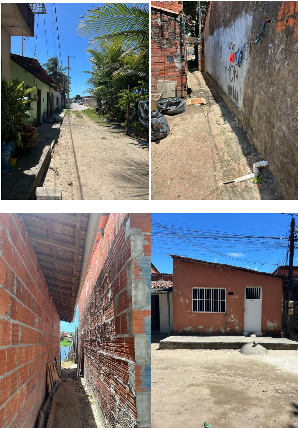
Figura 23 - Infraestrutura viária precária na Z1.
