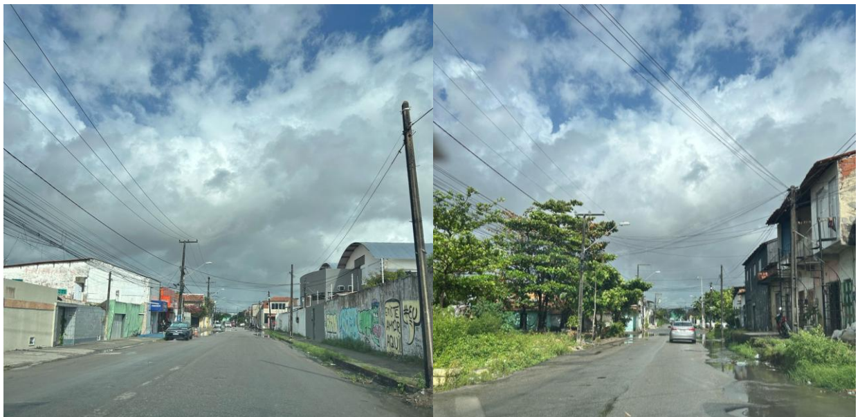
Figura 11 - Avenida José Leon.
