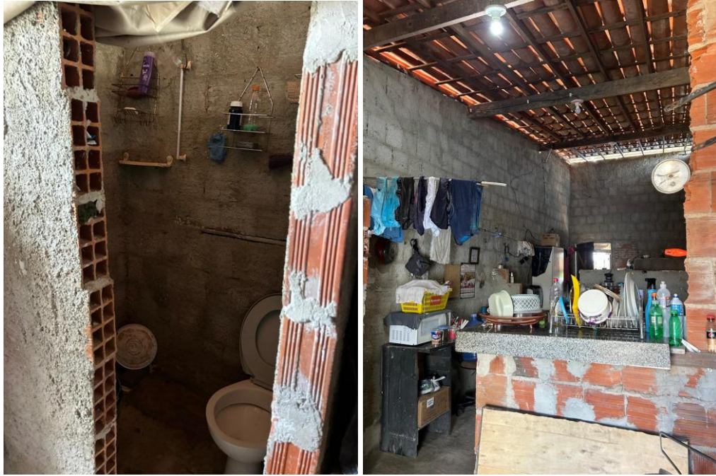
Figura 16 - Domicílio construído em alvenaria.
