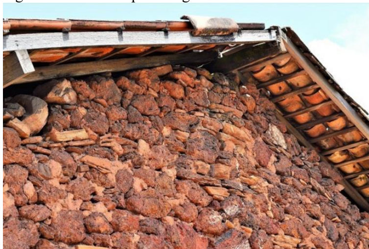
Figura 87 – Casa de pedra argamassada com barro em Ouro Preto
