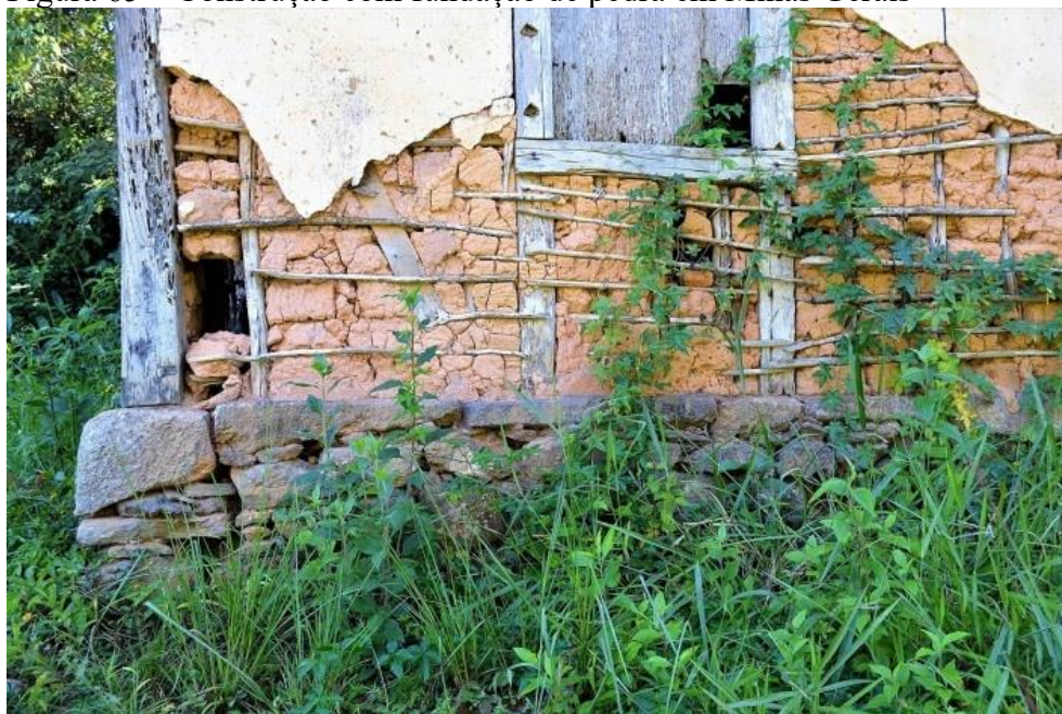
Figura 65 – Construção com fundação de pedra em Minas Gerais
