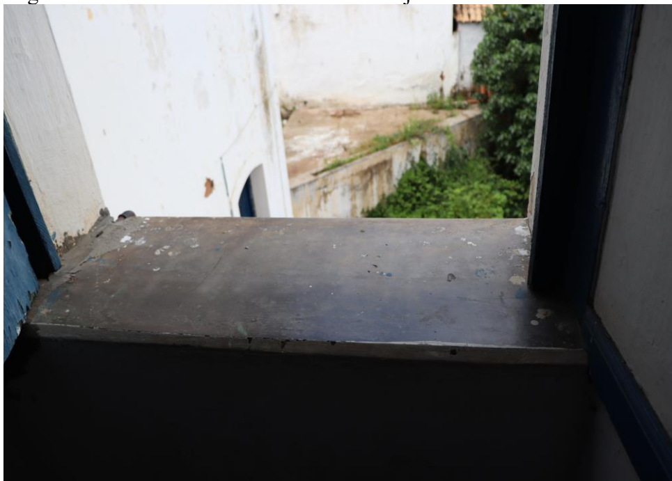
Figura 144 – Técnica de cantaria na base da janela
