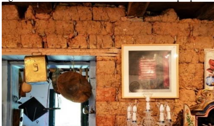
Figura 70 – Parte interna do sobrado com destaque para o adobe
