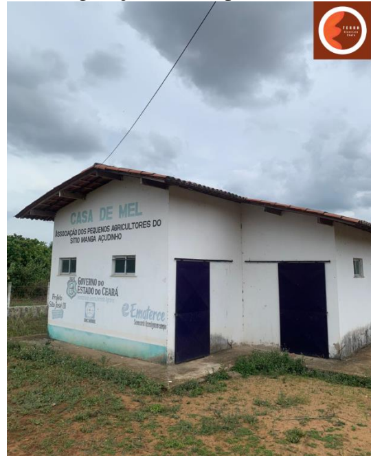
Figura 4 - Casa de Extração de Mel do PE Manga Açudinho, Capistrano, CE.
