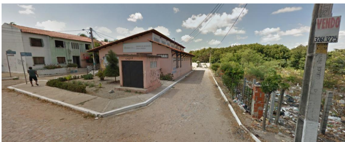
Figuras 55 – Prédios e casas populares, ao lado direito do açude, na Rua Viriato Ribeiro Ribeiro – ângulo 2
