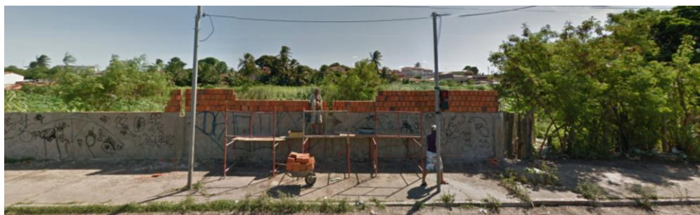
Figuras 88 – Muro do (antigo) Sítio Ipanema, na Rua Cel. Matos Dourado – parte 3
