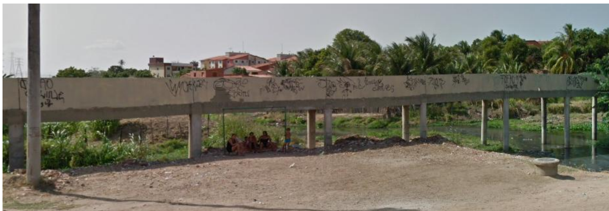
Figuras 104 – Riacho Cachoeirinha, na ponte entre Rua Doutor Pedro Augusto e Rua Doutor Vale Costa (Comunidade da “Chesf”) – parte 2
