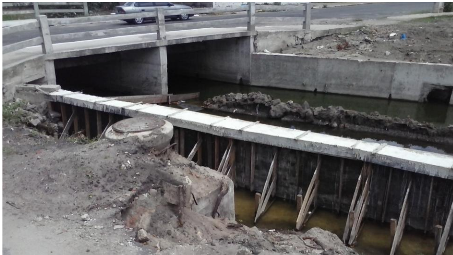
Figura 13 – Obra de canalização do Riacho Alagadiço ao lado de um vazamento de esgoto.
