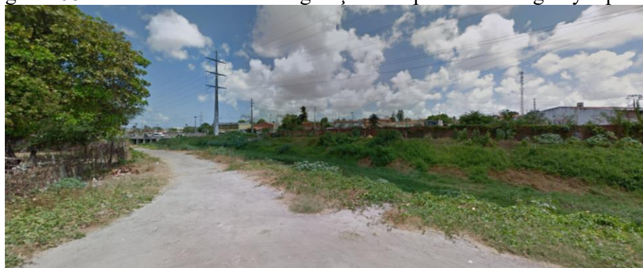
Figuras 68 – Trecho do Riacho Alagadiço visto pela Rua Periguary – parte 1
