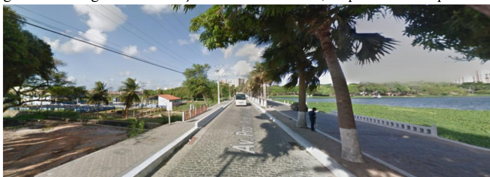
Figura 53 – Sangradouro do Açude Santo Anastácio, na ponte do Campus do Pici
