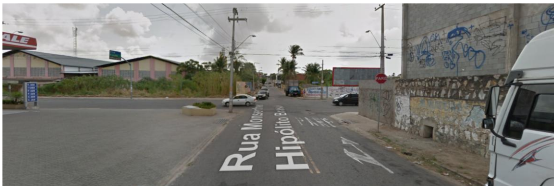
Figuras 80 – Trecho do riacho Cachoeirinha na encruzilhada da Rua Monsenhor Hipólito Brasil e Rua Professor Heribaldo Costa (Avenida Perimetral) – parte 1
