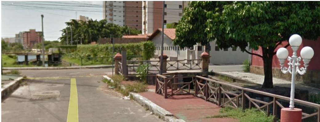
Figura 14 – Trecho do riacho Alagadiço canalizado ao lado de trecho com gabião (ao fundo).
