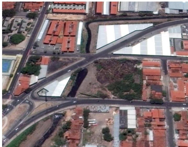
Figuras 21 - Depois no trecho entre Fábrica 3a Via (quadrante superior direito) e o Sítio Ipanema (quadrante inferior esquerdo), entre Avenidas.
