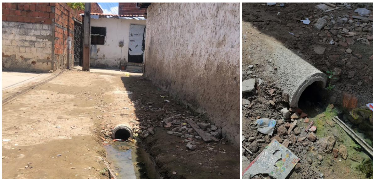
Figuras 35 e 36 - Uso de lixeira tubular de concreto como manilha improvisada
