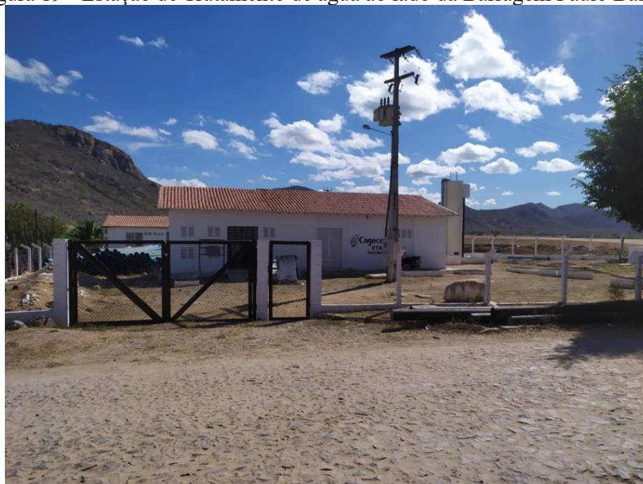
Figura 19 - Estação de Tratamento de água ao lado da Barragem Paulo Bastos.
