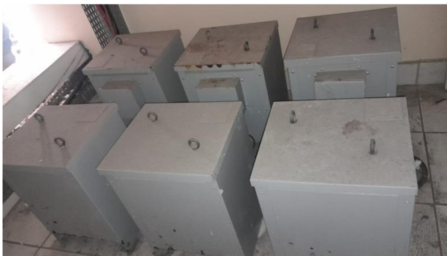
Figura 10 - Trafo Isolador
