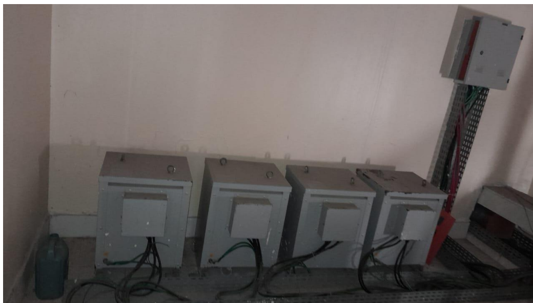
Figura 23 - Transformadores Isoladores
