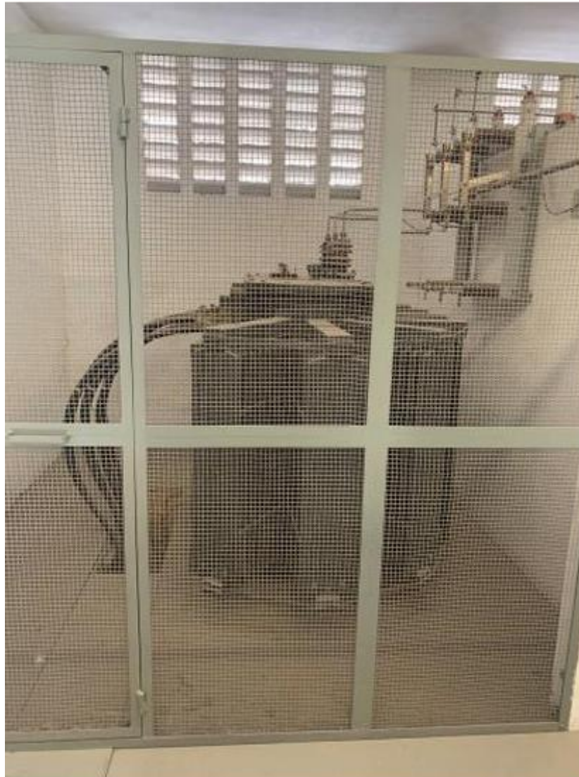
Figura 25 - Trafo 01- 500KVA
